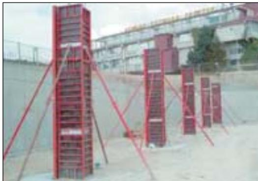
Los paneles de diferentes alturas que conforman el sistema, se van uniendo entre si hasta conformar el pilar, el cual debe estabilizarse mediante la colocación de los tensores (apuntalamientos) del propio sistema.
