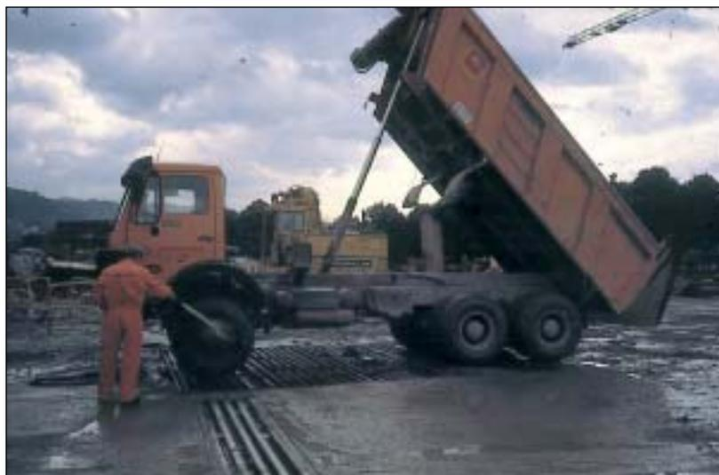
Si descarga material en las proximidades de la zanja o pozo de cimentación, se aproximará a una distancia máxima de 1,00 m., garantizando ésta, mediante topes. Todo ello previa autorización del responsable de la obra.
