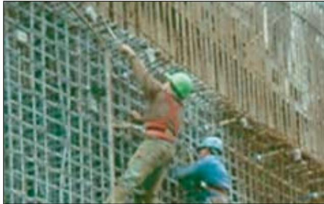
**Comprobar la correcta colocación de todos los elementos del encofrado** (cerrojos y grapas de amarre entre paneles, sujeción de ménsulas, plataformas y barandillas, accesos, estabilizadores, etc.) antes de su utilización, extendiendo el correspondiente **Certificado de montaje**.
