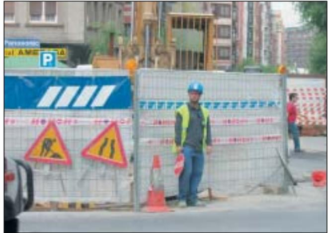
Es preciso adoptar las medidas necesarias para aislar dentro del recinto de la obra la posible generación de riesgos para que no afecten a terceros no intervinientes en la misma, mediante la colocación de vallas, luces, plataformas voladas, aceras suplementarias, señalización, etc.
