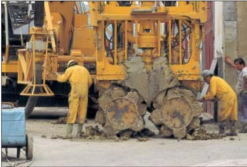
*Fresadora para muros-pantalla*
