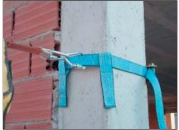
**Sistema para anclaje móvil a pilares**
