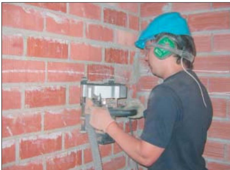
El mando de estas máquinas debe ser de presión, de forma que la misma se pare cuando se deje de apretar dicho mando.
