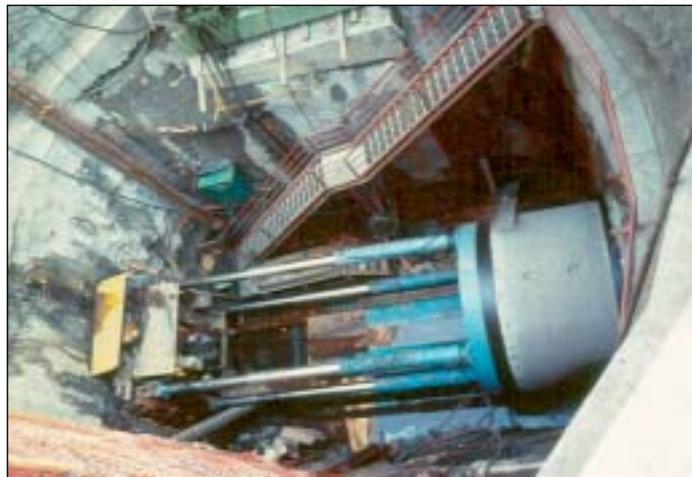
Para este sistema, hay que excavar dos pozos, de ataque y recepción y permite la colocación de tubos hasta 200 cm de diámetro, en longitudes hasta 600 m.
