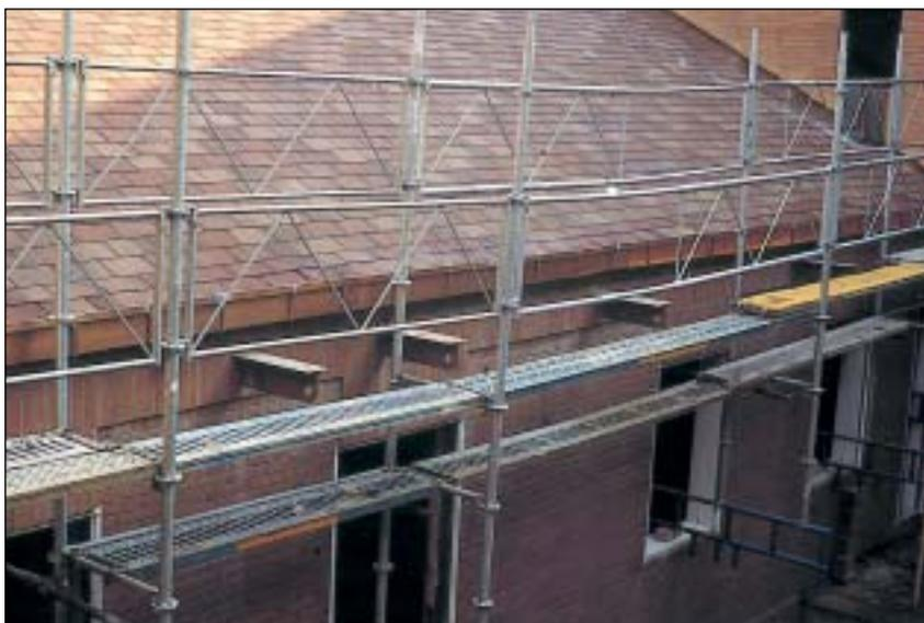
Este tipo de protección se hace muy necesario para la realización de remates de aleros en general y remates de aleros en voladizo, en particular. En estos casos se puede hacer el andamio a partir de una estructura tubular que vuele por las ventanas más próximas a cubierta.
