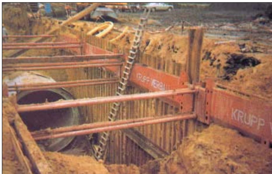
En la parte superior de la zanja, las tablestacas se apoyan sobre el panel con cámara. Según la profundidad de la zanja, las tablestacas se empotran en el fondo de la zanja para así obtener un contrafuerte, o -si las condiciones estáticas así lo requieren- se establece un acodalado adicional mediante vigas de refuerzo y codales.
