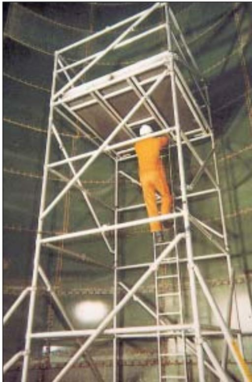
***Plataformas para montaje de instalaciones en altura***
