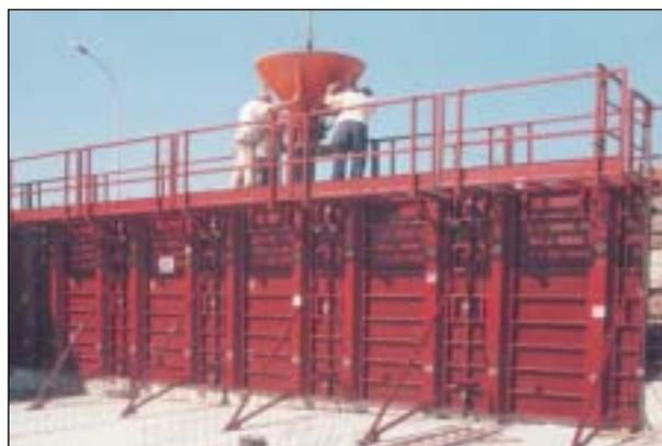
Todos los sistemas de encofrado deben disponer de una plataforma de trabajo, con su correspondiente barandilla y escalera de acceso, desde la cual se puede verter y vibrar el hormigón. Si el encofrado es a 2 caras, se deben disponer plataformas de trabajo (con su barandilla) en ambas caras, o al menos barandilla en la que no se use como plataforma
