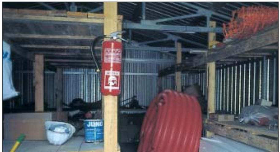
El emplazamiento de los extintores se elegirá en la proximidad de los lugares donde se pueda dar un conato de incendio, **deben estar visibles y fácilmente accesibles** y no quedarán escondidos detrás de otros materiales. Deben colocarse sobre soportes de forma que la parte superior del mismo esté como máximo a 1,70 m. del nivel del piso.
