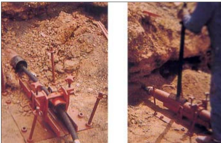
El cohete o topo mecánico consiste en una carcasa alargada dentro de la cual bate un émbolo mediante su unión por manguera a un compresor. Mediante este movimiento de percusión, el cohete es impulsado a través del terreno, a consecuencia de cuyo desplazamiento se produce un tubo compactado de tierra dentro del cual pueden ser inmediatamente introducidos o embutidos tubos tanto de conducción como de protección.
