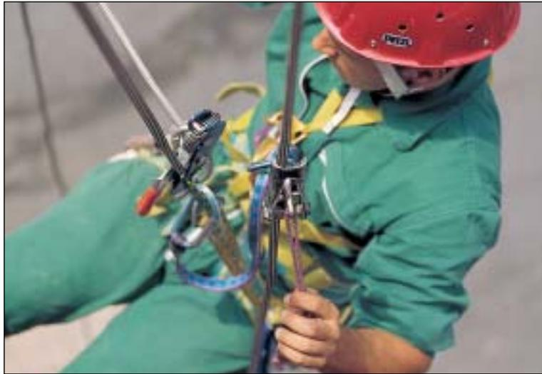
El efecto yo-yo es un movimiento vertical hacia arriba y abajo debido a la elasticidad de las cuerdas y que aumenta cuanto más lejos está el punto de anclaje del trabajador. **El fraccionamiento** (incorporar un punto de anclaje intermedio en la cuerda) es la solución cuando el efecto yo-yo es tan pronunciado que impide realizar el trabajo cómodamente. El punto de anclaje del fraccionamiento suele ser mecánico o químico.
