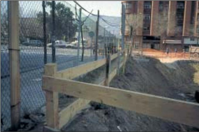
La colocación de una valla de cierre en la obra, no exime de la colocación de barandillas en el interior si hubiera una zona de paso, pegando a la valla, al borde de excavación o muro de sótano.
