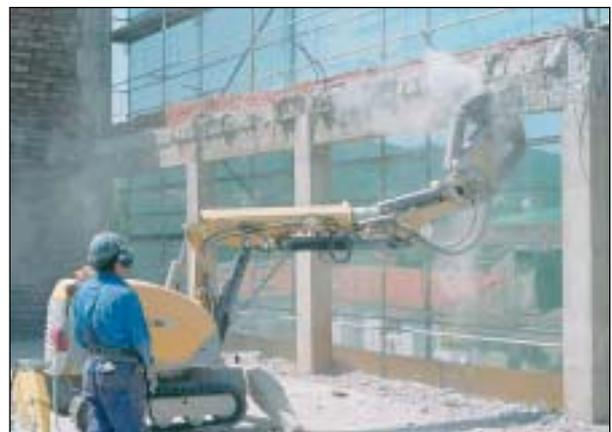
**Robot de demolición**
