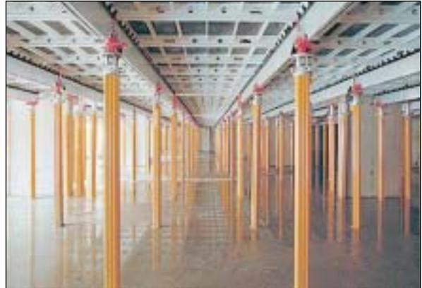
Algún sistema utiliza vigas de madera de sección **I** (de apoyo y de reparto) en lugar del entramado metálico, yendo los puntales colocados sobre trípodes de apoyo.
