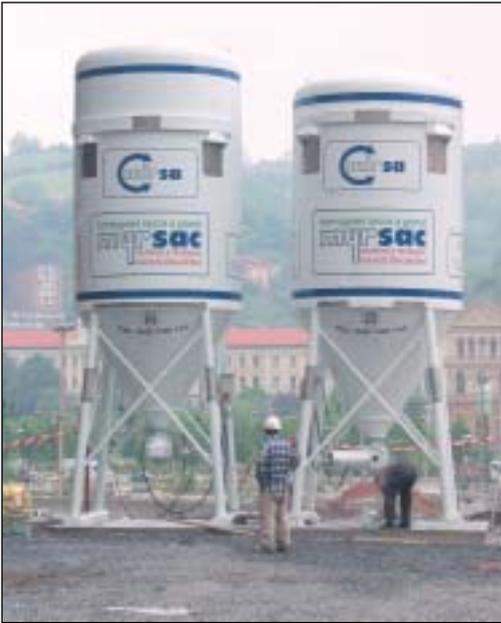
**Silos para mortero con mezclador**
