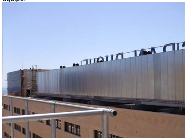
Figura 04. Detalle de la instalación de pantalla
