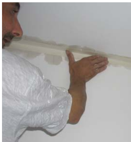
Detalle ESV-02.c.R3. Remate de la junta
