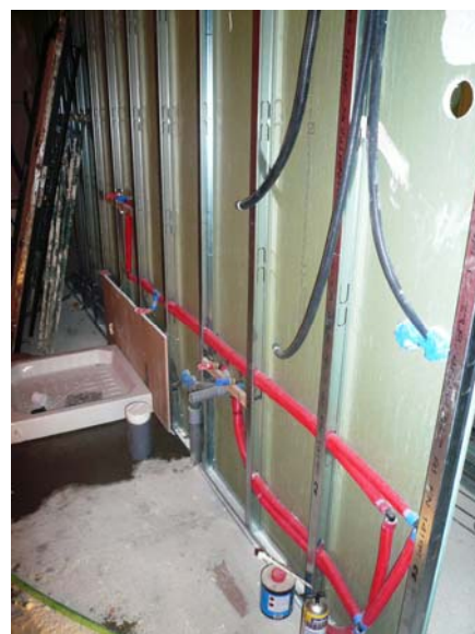
Detalle ESV-03.b.R3. Instalación correcta de las tuberías entre los perfiles de las placas de yeso laminado
