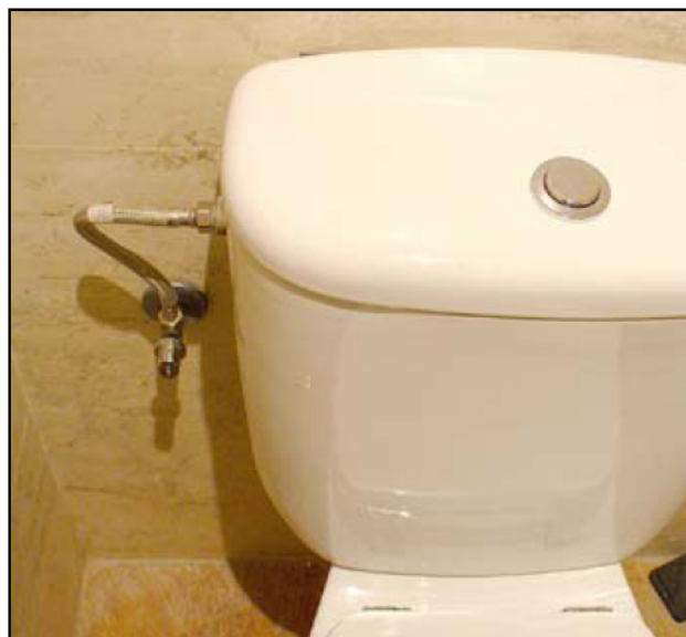
Figura CH-5. Conectores flexibles y junta elástica desolidarizadora
