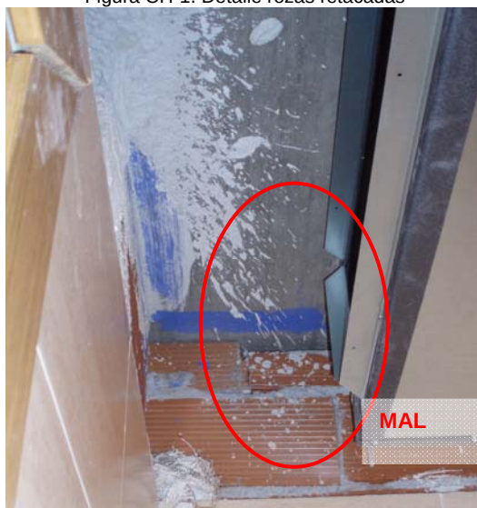
Figura CH-2. Detalle encuentro forjado partición
