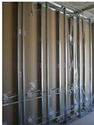
Detalle ESV-03.b.V3. Instalación incorrecta de las instalaciones. Deben evitarse los contactos rígidos entre las hojas de las placas
