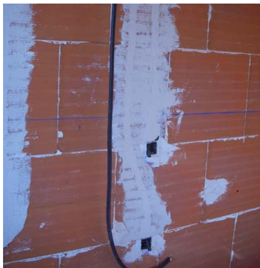
Figura CH-1. Detalle rozas retacadas
