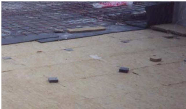
Figura R_INST-02. Ejemplo de un suelo flotante
