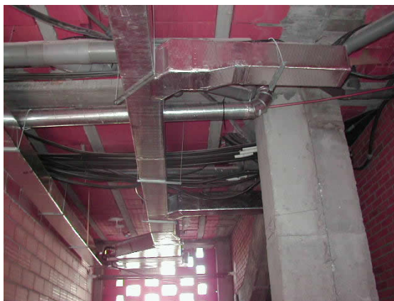
Figura CP-10. Ejemplo distribución de la red de conductos de climatización
