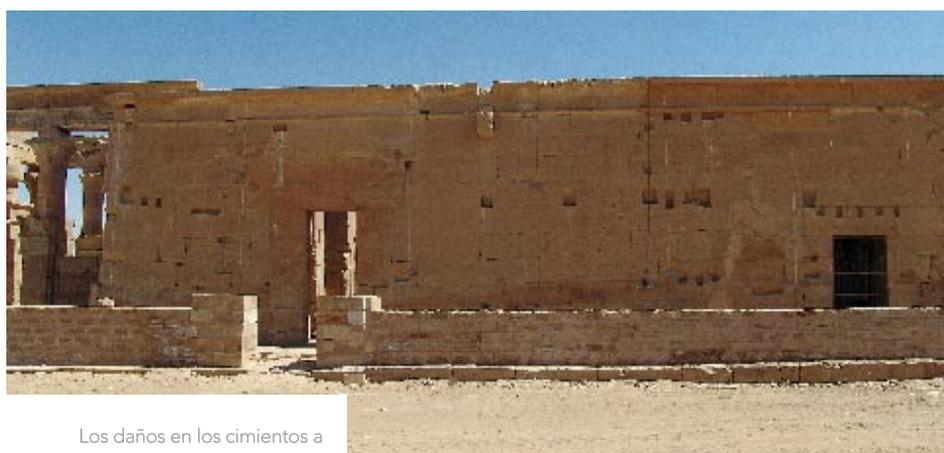
Los daños en los cimientos a causa de las aguas subterráneas provocaron desplazamientos en muros y pórticos exteriores.
