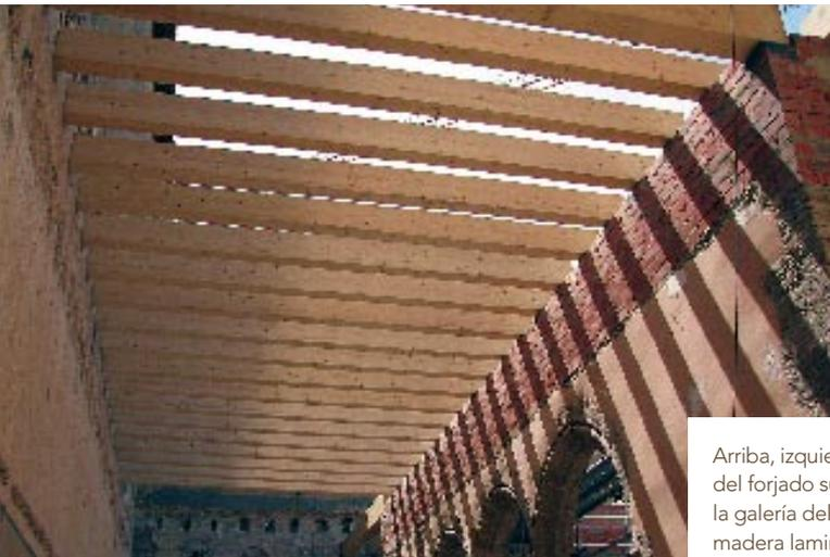
Arriba, izquierda, ejecución del forjado superior de la galería del patio con madera laminada.
