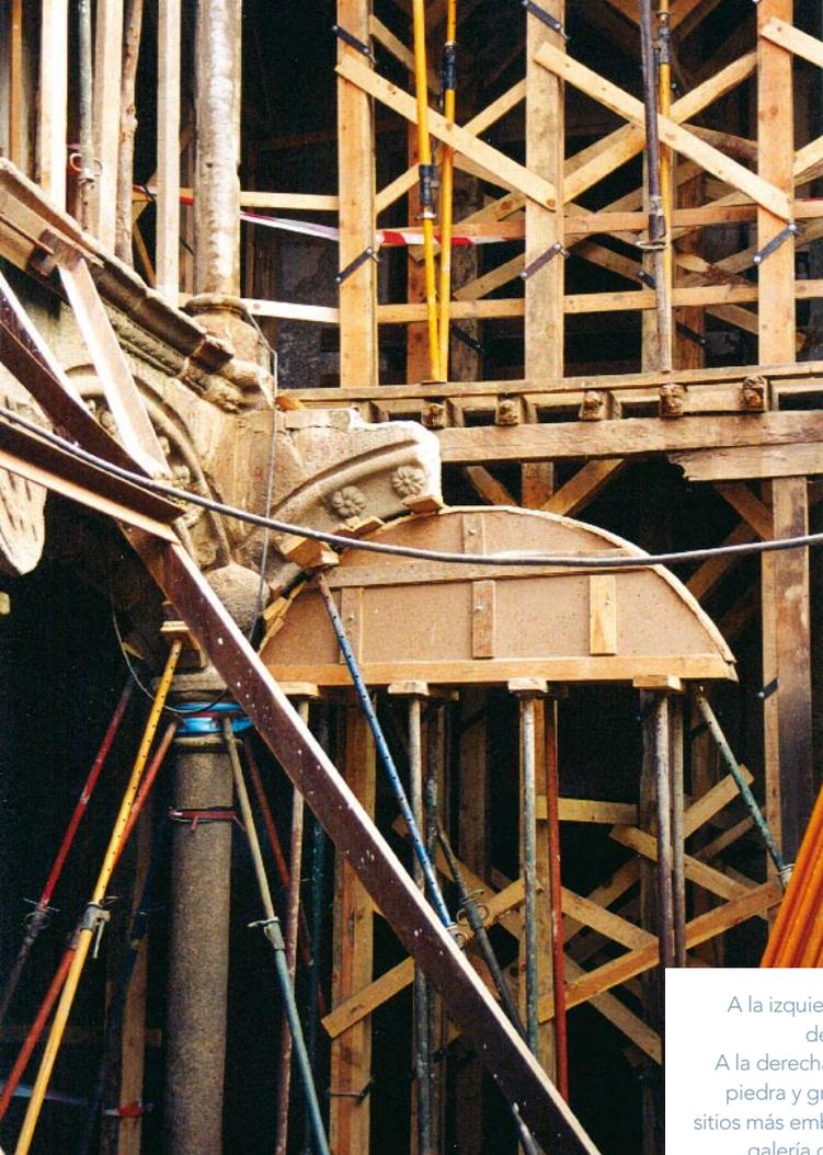
A la izquierda, proceso de desmontaje de los arcos de la galería Este. A la derecha se observa cómo el uso de piedra y granito estaba reservado a los sitios más emblemáticos: fachada exterior, galería del patio y escalera principal.
