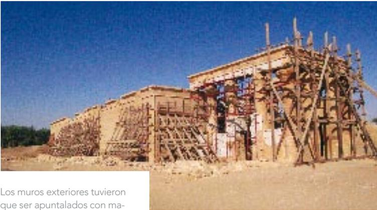
Los muros exteriores tuvieron que ser apuntalados con madera para evitar su derrumbe. Abajo, barra de anclaje con la que se inyecta el mortero especial en baja presión con el que se ha rehabilitado el templo.
