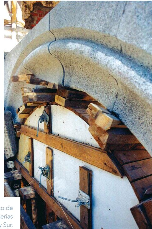
numeradas todas las dovelas de granito de los arcos, así como basas, fustes y capiteles de ambas galerías, para su posterior montaje en su mismo lugar y garantizar el correcto funcionamiento estructural.
