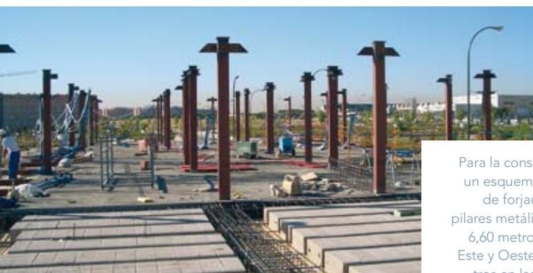
Para la construcción, se realizó un esquema estructural mixto de forjados de hormigón y pilares metálicos, con crujiás de 6,60 metros en la orientación Este y Oeste, y de 4 y 5,10 metros en las caras Norte y Sur.
