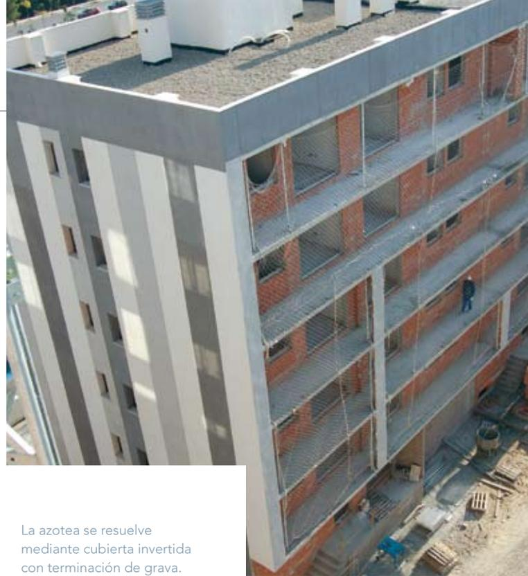
La azotea se resuelve mediante cubierta invertida con terminación de grava. Sobre ésta se apoyan las losas que funcionan como lastre de los paneles solares.
