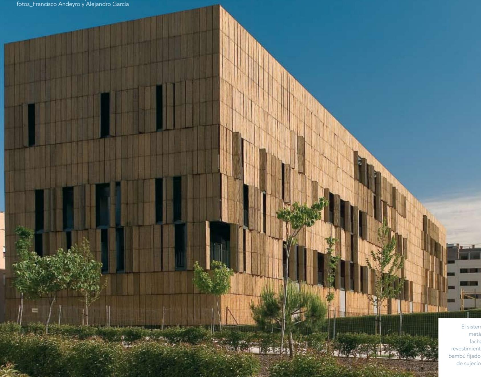
El sistema móvil de bastidores metálicos que constituye la fachada contiene un doble revestimiento natural de cañizo de bambú fijado al bastidor por medio de sujeciones metálicas de PVC.
