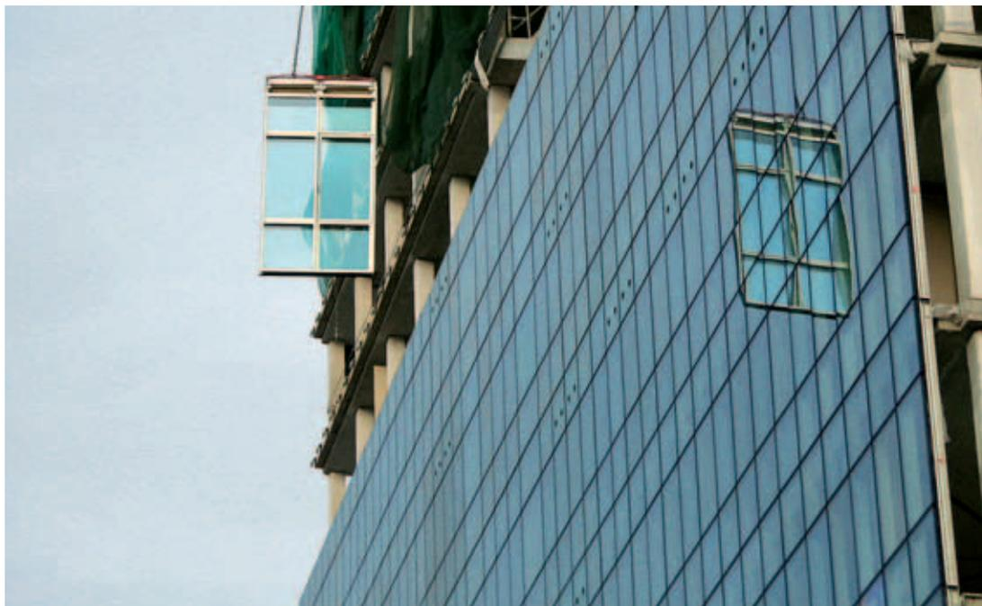
La fachada de los dos edificios principales está formada por un muro cortina de vidrio con una superficie de 15.000 m<sup>2</sup>. Para su colocación se ha utilizado el sistema de fachada modular, el primero en el mundo que emplea la silicona para unir el vidrio al bastidor de aluminio combinado con la apertura al interior de las ventanas
