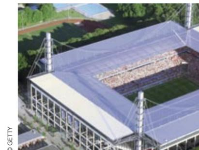
El estadio de Colonia ha sido reconstruido en 2002 bajo el diseño de los arquitectos de GMP Von Gerkan, Marg und Partner y Aachen Hamburg. Tiene cuatro mástiles de 72 metros de altura que sostienen el techo.
