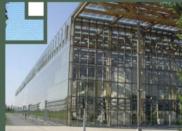
LA AMPLIA GAMA DE COLORES, SOMBRAS Y CONTROL DE LUMINOSIDAD DEL VIDRIO FOTOVOLTAICO, ASÍ COMO SU MODULACIÓN A LA HORA DEL MONTAJE, DAN MÁS POSIBILIDADES A LA HORA DE INTEGRAR ESTE MATERIAL AL DISEÑO DE UN EDIFICIO
