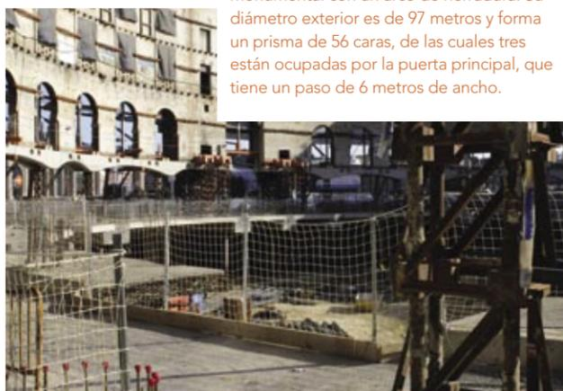
“ Para el apeo vertical durante la ejecución de la obra, la solución más lógica era la que provocase únicamente una deformación vertical, dada por axil. Así, la única solución posible era colocar dicho apeo en el mismo eje de la fachada, y la opción más sencilla por simplicidad estructural y aprovechamiento del espacio era el pilotaje. ”
