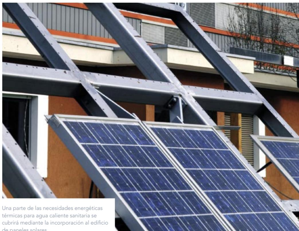
Una parte de las necesidades energéticas térmicas para agua caliente sanitaria se cubrirá mediante la incorporación al edificio de paneles solares.
