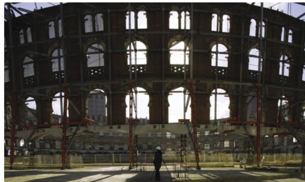
"V". Una vez ejecutadas, éstas se usarían también en la fase de apeo provisional, de manera que su simple unión postesada a través de la fachada mediante barras MKY 1030 W de diámetro 32 mm a una tensión de 70 Tn y su unión soldada a encepados metálicos anclados a la parte superior de las vigas, los cuales sujetarían los micropilotes a su paso por los mismos, pudiesen transmitir la carga de la fachada a los micropilotes una vez descalzada la base de la misma.
