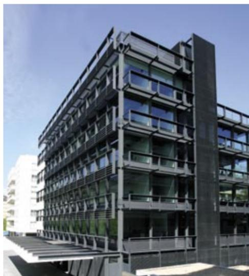
volúmenes de cristal rodeados de ligeras galerías perimetrales, que posibilitan la limpieza de los vidrios que cierran los espacios de trabajo, construidas con suelos de tramex apoyados sobre viguetas metálicas voladas de la estructura colocada en la líneas de fachadas.
