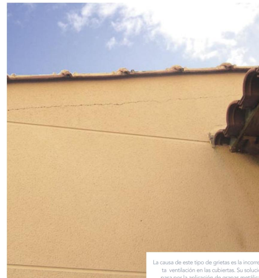
La causa de este tipo de grietas es la incorrecta ventilación en las cubiertas. Su solución pasa por la aplicación de grapas metálicas.
