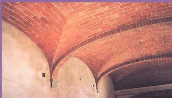
Arriba, trasdós de una bóveda tabicada terminada y colocación del arco auxiliar. Abajo, bóvedas consecutivas apoyadas en arcos auxiliares.
