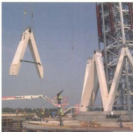
Se desarrolló un procedimiento de ejecución que se basaba en la colaboración mutua entre el fuste central y la estructura portante principal prefabricada. Para evitar la necesidad de utilizar grandes y aparatosos andamiajes, la estructura interior del fuste se ha utilizado como base para el montaje de las piezas prefabricadas.
