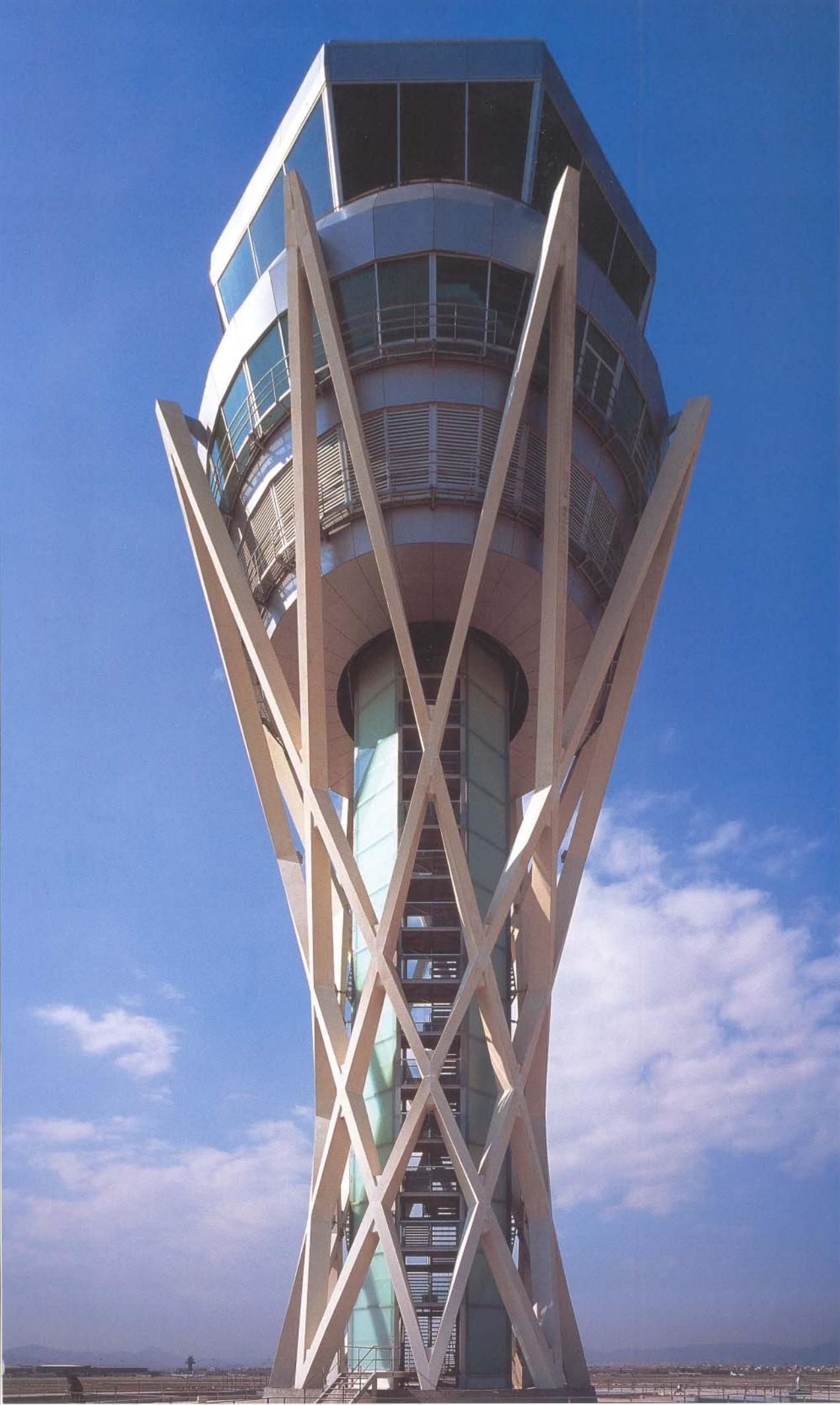
La característica más sobresaliente de la torre es la estructura hiperboloide del fuste, ejecutada mediante directrices que arrancan de ocho puntos situados en la circunferencia de la base.
