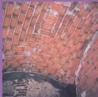
Ejecución de la bóveda tabicada mediante hiladas de ladrillo recibidas con pasta de yeso.
