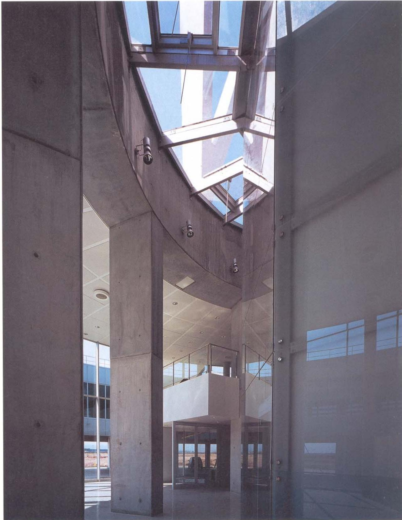
La estructura se basa en el empleo extensivo de la prefabricación, entendiendo los elementos resistentes como piezas arquitectónicas y estructurales a la vez.
