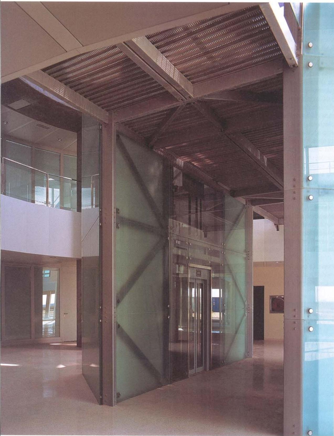
Con un empleo muy limitado de materiales –hormigón prefabricado, acero y aluminio extrusionado– se ha conseguido una estructura que proporciona características de resistencia y rigidez muy elevadas, permitiendo además vertebrar el programa funcional de la torre.
