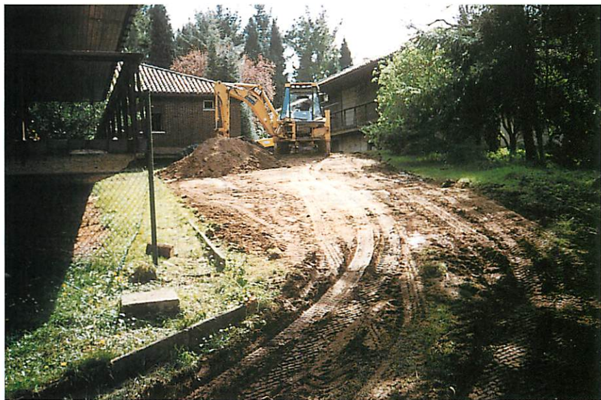
Fase de preparación de los accesos.
