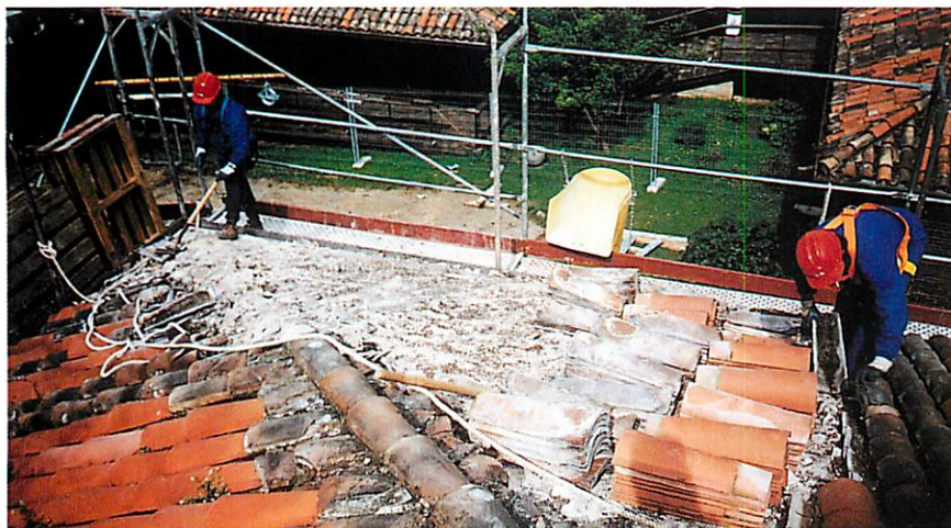
Toda la teja de cubierta fue levantada de forma manual.
