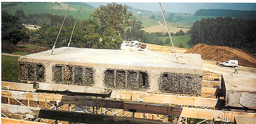
Momento de la retirada de porción del forjado.
