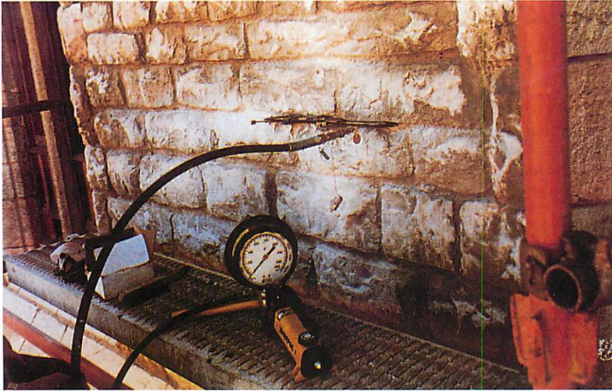
Estimación del estado tensional de un muro de fábrica mediante gato plano.
