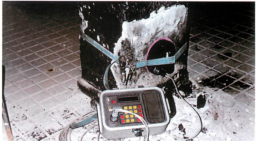
Aspecto del equipo GECOR6 durante la realización de la medida de corrosión.
