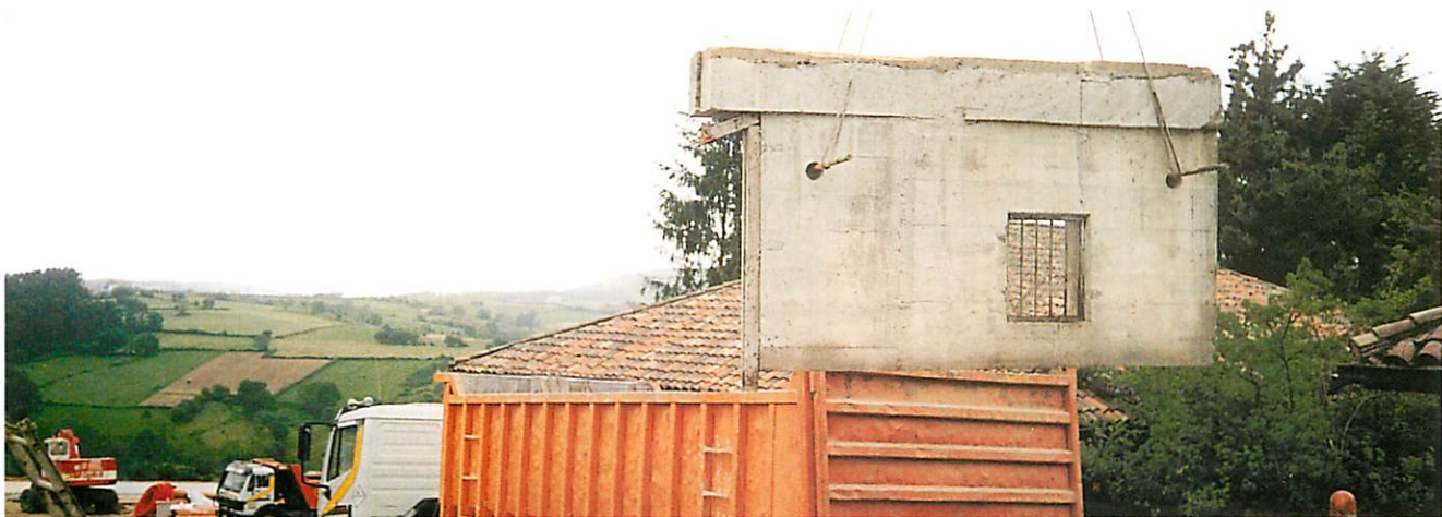
Porción de muro del edificio trasladada al camión para su retirada.
