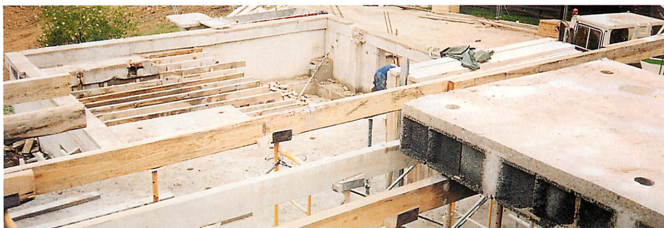
Foto en la que se aprecia el forjado de cubierta (en primer plano) y el de la planta baja.
