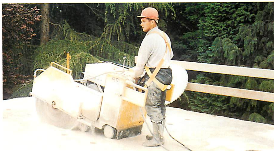
Se ha utilizado un sistema de demolición basado en el corte con disco y cinta.
