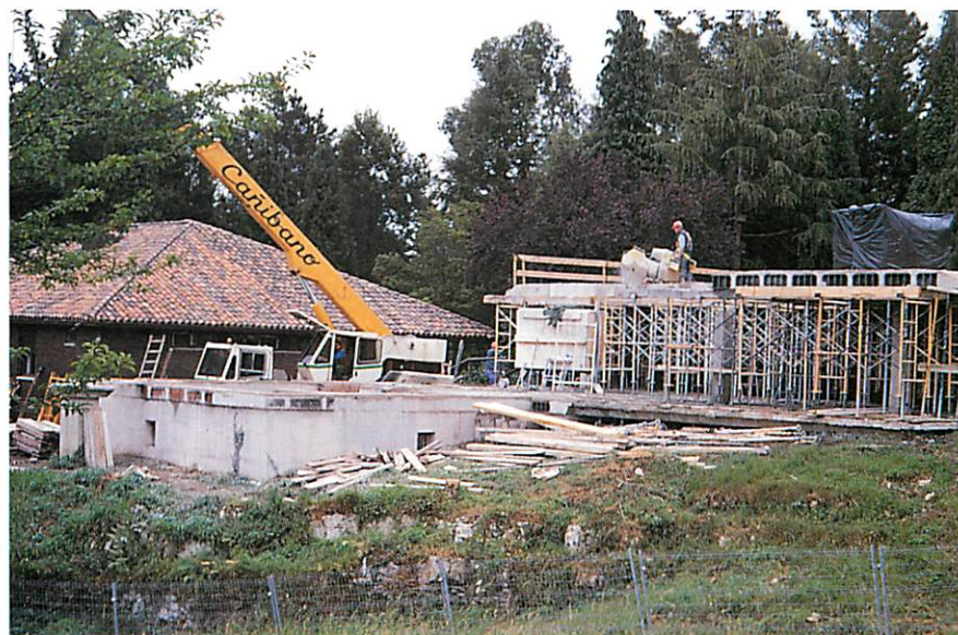
Se utilizaron sistemas de demolición que no produjeran percusión.
