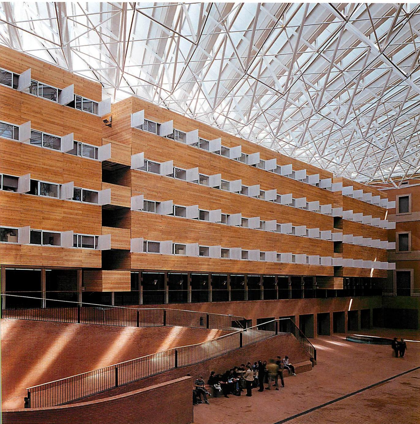
Los edificios interiores de nueva planta se construyeron con estructura metálica. Uno, el aula, es de estructura metálica recubierta de hormigón, con pórticos paralelos a toda luz de su anchura y estabilizados por pantallas de hormigón en los testeros.
