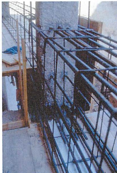
Figura 8. Anclaje armaduras
