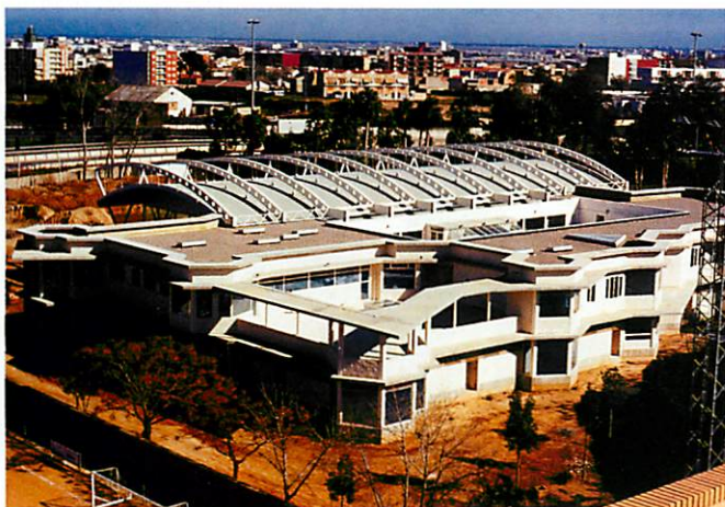
Obra: Piscina Municipal Picassent (Valencia)
