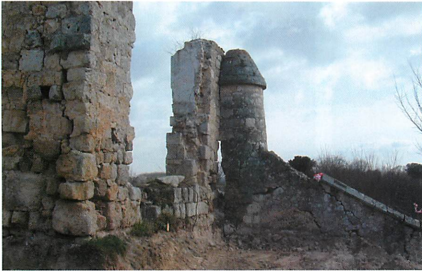
Sus fábricas han sido testigos de sucesivas reformas, destrucciones y restauraciones.
