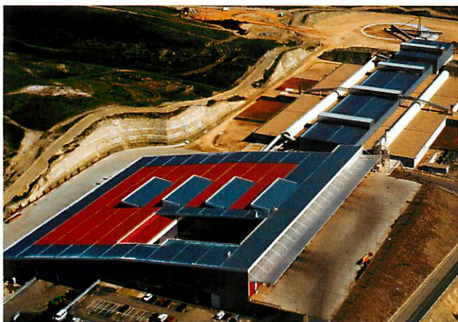
Obra: Vertedero Valdemingomez (Rivas - Madrid)
