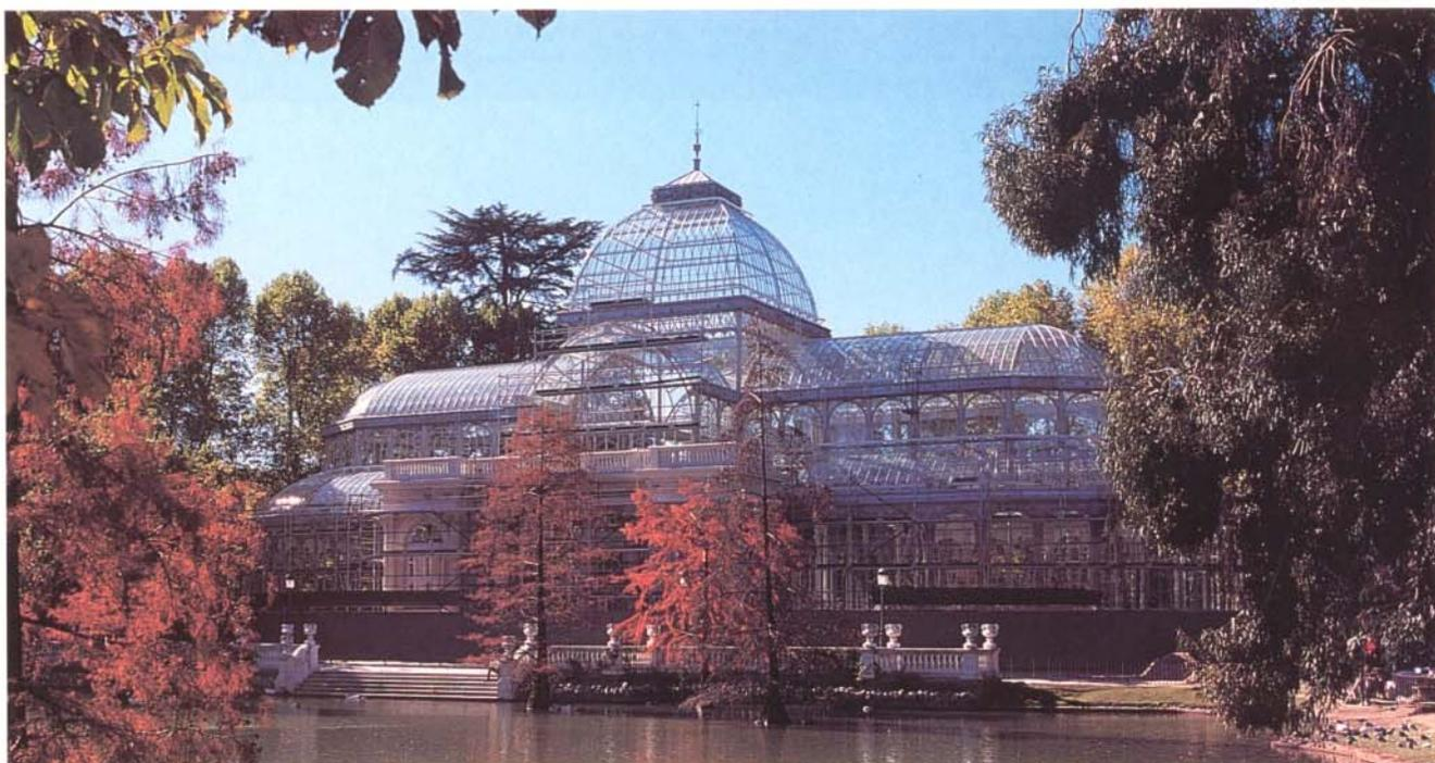
**L**a estructura del Palacio está configurada por un sistema de pilares en dos niveles, de los que parten unos elementos de perfiles T acartelados con roblones a modo de cerchas curvas que configuran las bóvedas en los dos niveles y forman la cúpula central de cuatro lados.
