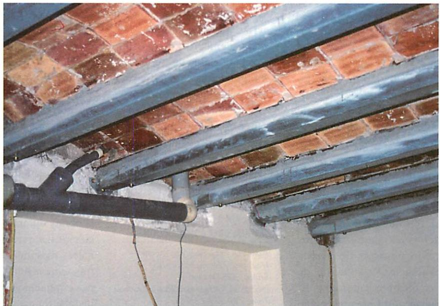
El sistema D.I.T. 289, una vez montado, ofrece un refuerzo activo a la estructura.
