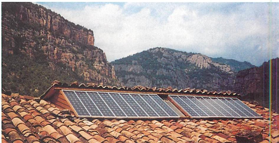
La energía solar puede integrarse en la construcción tradicional.
