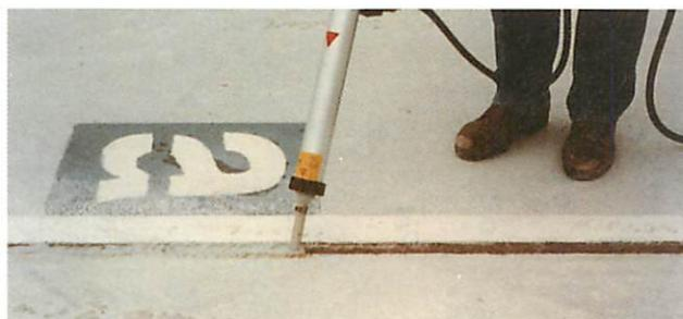
La masilla escogida para el sellado de las piezas prefabricadas del aparcamiento barcelonés presenta una elasticidad permanente de un 15 por ciento y una muy buena resistencia al desgaste por abrasión, punto este último importante, por cuanto las juntas selladas se hallan en posición horizontal en una superficie destinada al tránsito.
