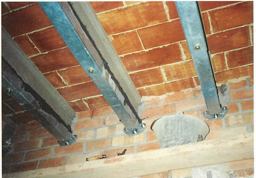
Detalle de soportes y anclajes del nuevo sistema, unidos a vigas deterioradas.
