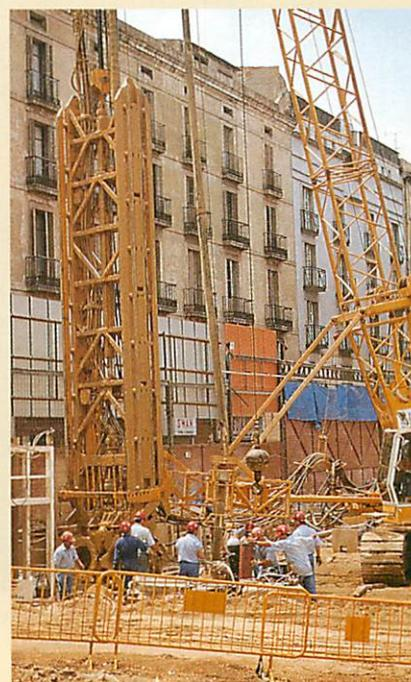
El detritus que proviene de la bomba de la máquina se somete a un cribado previo para la eliminación de gruecos, pasando posteriormente a una cuba de nivel constante, desde donde es bombeado el lodo al hidrociclón, separando las partículas mayores de 110 micras.
