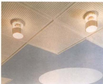
versiones -perfilada y lisa. Las perforadas se puede elegir entre tres diseños diferentes. La regulación vibratoria del sonido se consigue combinando la absorción por membrana y la resonadora. Así, la placa lisa absorbe primordialmente las frecuencias de sonido más bajas y las placas perforadas, que van cubiertas por una tela insonorizante o con lana mineral, cumplen la función de absorción resonadora.
