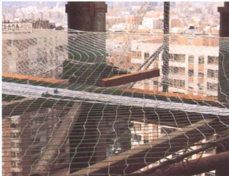
Red horizontal de protección montada entre dos alturas.
