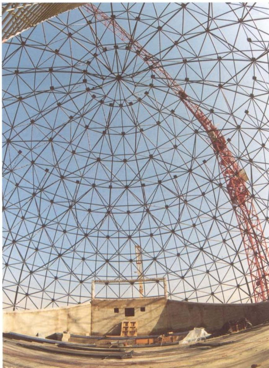
**La estructura metálica está recubierta de hormigón GCR.**
