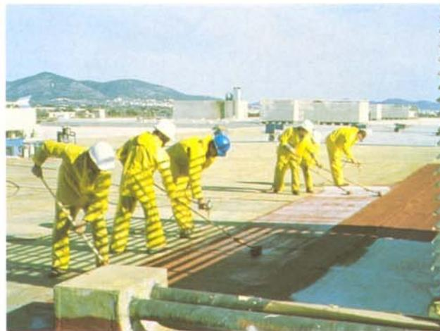
**Aplicación y proceso completo de impermeabilización por embebido de armaduras.**
