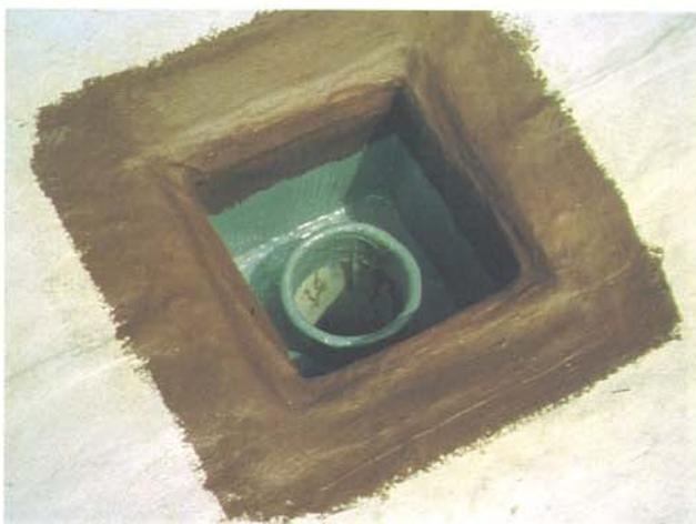
Aplicación de acabado y protección. Abajo, refuerzo en punto singular (sumidero).
