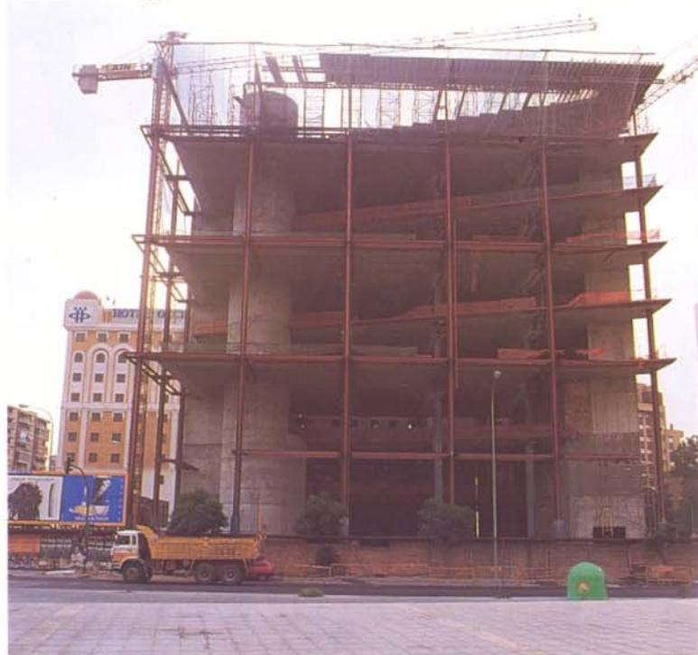
**Estructura metálica de la fachada principal. Al lado, planta y alzados del nuevo edificio sevillano.**
