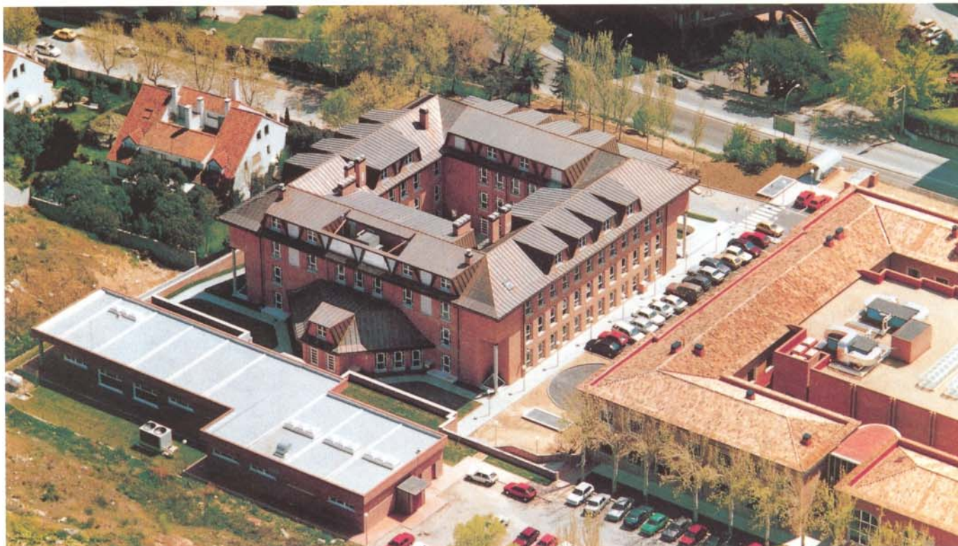
Cubierta de cobre para la Escuela Fiscal del Ministerio de Economía y Hacienda en Madrid
