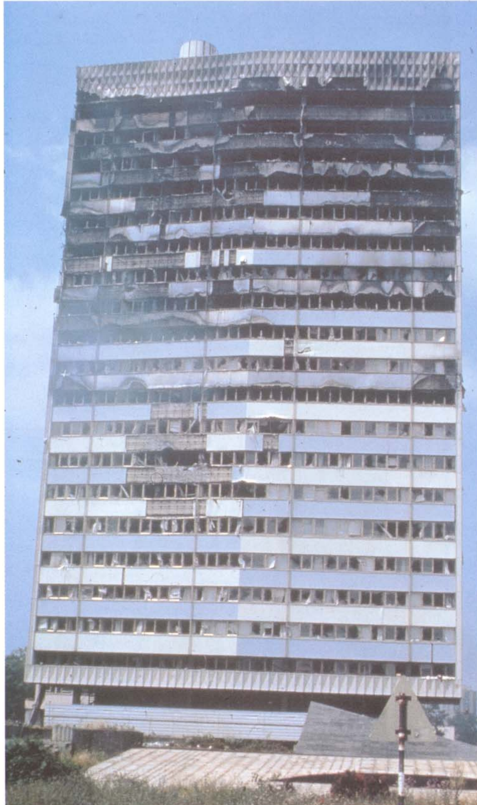
Uno de los edificios de Sarajevo que ha sufrido daños considerables.
