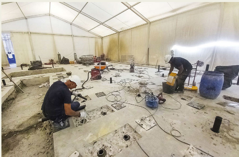
Fijación de los micropilotes a la losa.
