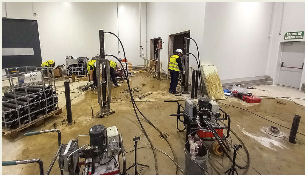
Vista general de los trabajos de recalce.
