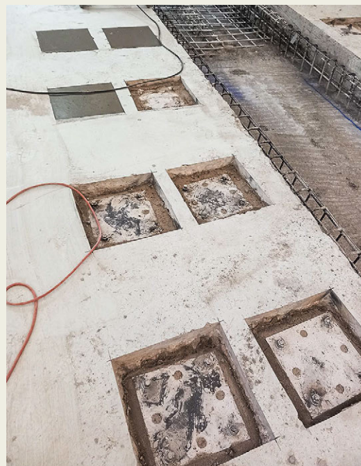
Colocación de placas antipunzonamiento.
