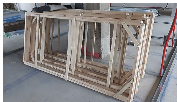
Fig. 3: acopio en planta de varios precercos de madera de puertas de paso abatibles.
