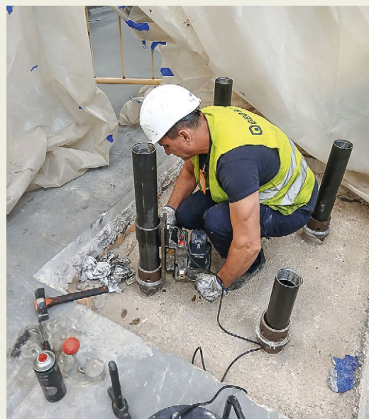
Fijación de los micropilotes a los tubos-camisa.
