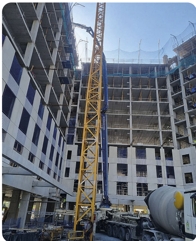
Edificio Node Barakaldo en construcción
