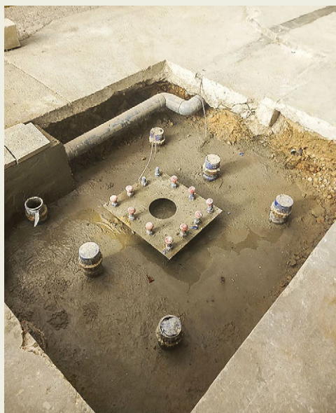
Encepado con placa de anclaje del pilar y tubos-camisa preparados para la hinca del micropilote.
