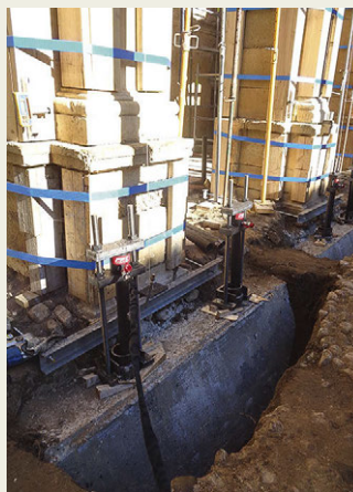
Estabilización y recalce de la arquería de un claustro en un monasterio de la provincia de León (siglos XII-XVI). Técnica: micropilotes GROUNDFIX® con recuperación de asentamiento.
