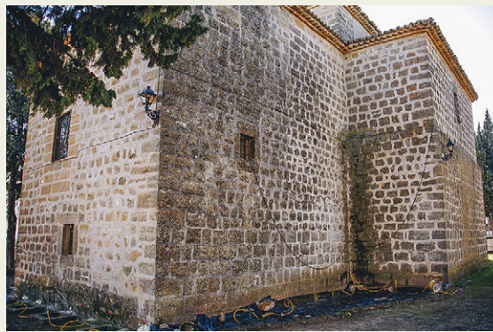
Arriba, intervención con inyecciones de resina expansiva en iglesia de Sabiote (Jaén). Derecha, intervenciones de GEOSEC® en una iglesia parroquial, en la provincia de Guadalajara.
