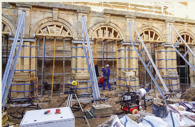
Estabilización y recalce de la arquería de un claustro en un monasterio de la provincia de León (siglos XII-XVI). Técnica: micropilotes GROUNDFIX® con recuperación de asentamiento.
