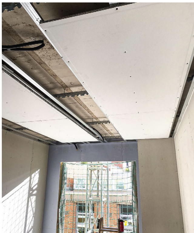
Montaje en techo del panel radiante de baja entalpia Sunthal Dress
