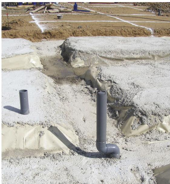
Fig. 6: instalación de saneamiento colocada bajo una lámina de PVC y el hormigón de limpieza de una losa nervada de cimentación.
