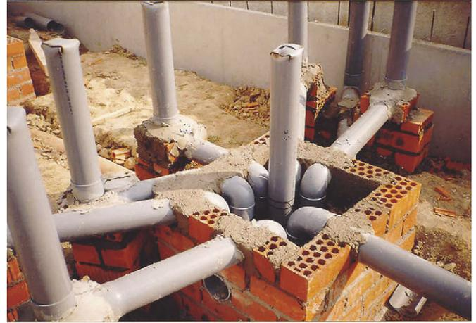
Fig. 5: acumulación excesiva de tuberías por una falta de previsión en proyecto para el correcto cálculo de la red.
