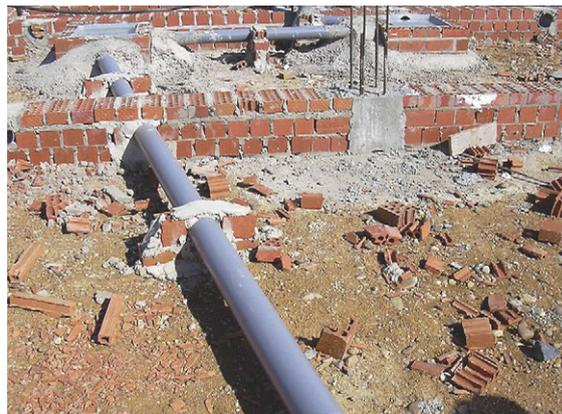
Fig. 2: red de tipo ‘oculta’, dispuesta sobre apoyos de ladrillo.
