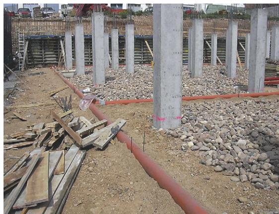
Fig. 1: red de tipo ‘cubierto’, apoyada sobre cama de arena.
