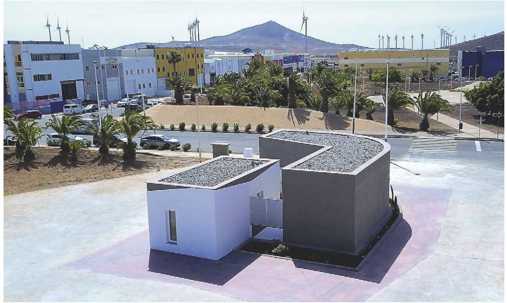
Este edificio, compuesto por dos volúmenes diferenciados de una sola altura, se ha levantado utilizando la tecnología Evoconstructor®, que integra inteligencia artificial, robótica e impresión 3D.
