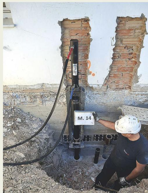
Identificación de micropilote Groundfix® durante la ejecución y registro de la presión de hinca alcanzada. Fuente: archivo GEOSEC.
