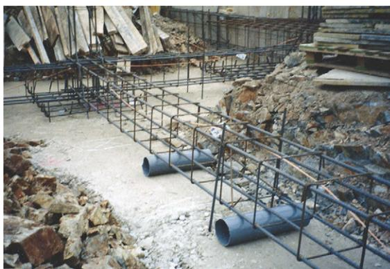
Fig. 7: disposición de la red de saneamiento por debajo de las riostras, con colocación de pasatubos antes del hormigonado.
