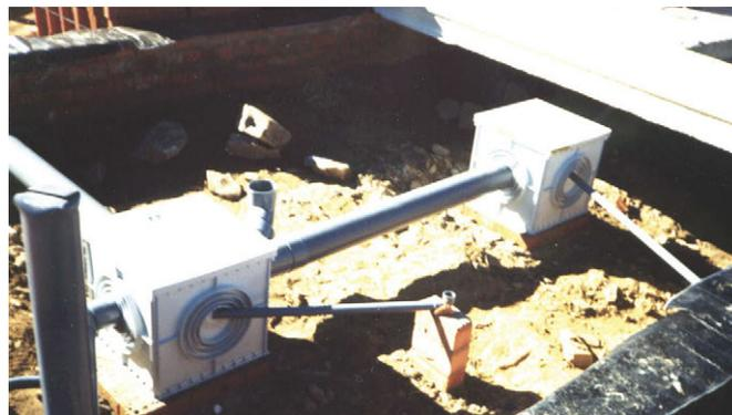
Fig. 8: red de saneamiento bajo forjado sanitario realizada con arquetas prefabricadas y tuberías de PVC de pared lisa. Se observa que los apoyos están mal concebidos y no son suficientes.
