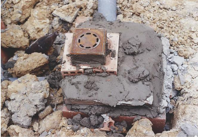
Fig. 4: incorrecto diseño y ejecución de un sumidero de patio sobre una arqueta.
