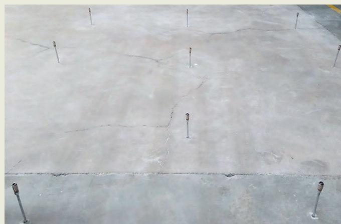
Intervención bajo placas con inyecciones en cuadrícula.
