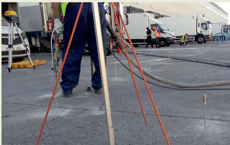
Control por nivelación láser.
