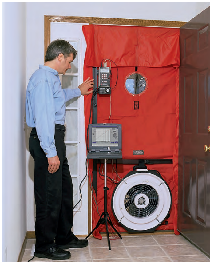
Fig. 8: proceso de control durante la realización del ensayo "Blower Door" en la puerta de entrada de una vivienda.
