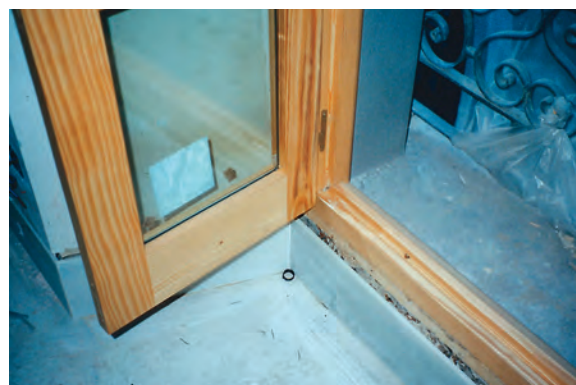
Fig. 2: colocación de vidrio en carpintería de madera.
