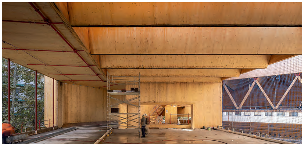
La estructura de este edificio de 4.170,29 m 2 distribuidos en cinco plantas es híbrida de madera y acero.
