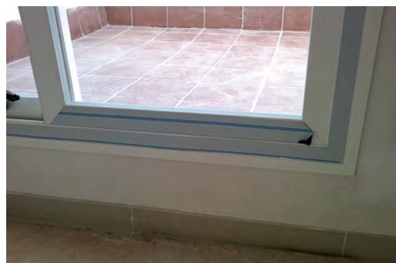
Fig. 2: montaje de puerta corredera de acceso a una terraza.
