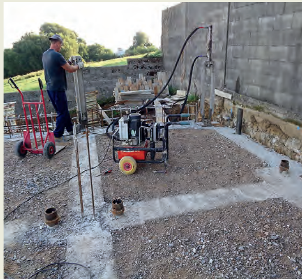
A la izquierda, ejecución de cimentación de nueva construcción. Al lado, dispositivo de hinca del sistema GROUNDFIX®.
