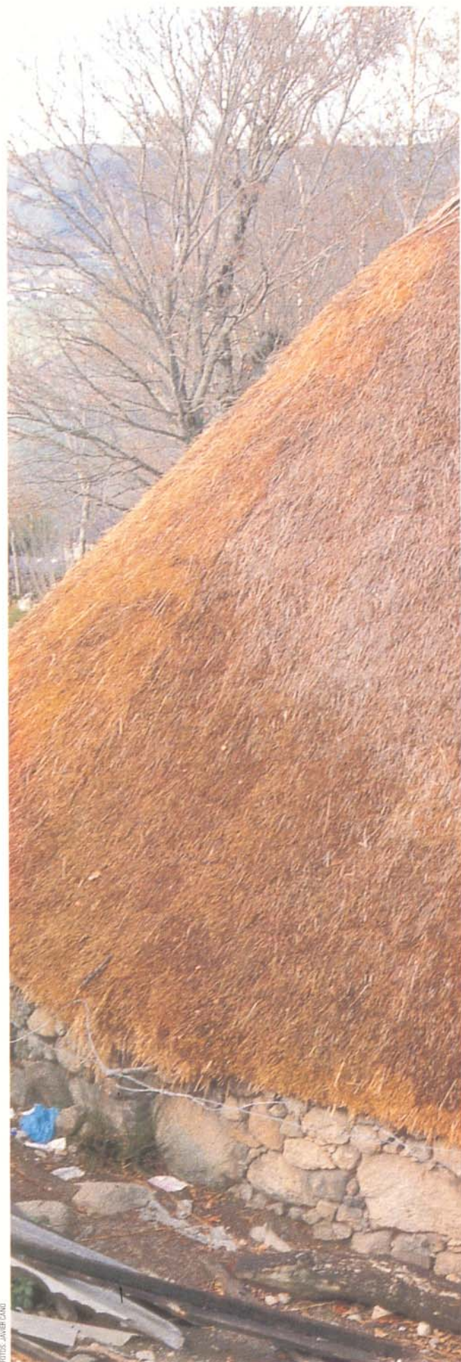
Arriba, en Uzlarello (Lugo) detalle del muro y tejado de paja de una palloza. A la derecha, un ejemplo de esta arquitectura exhibida en el museo de Piornedo (Lugo).
