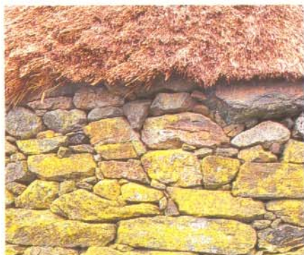
Arriba, en Uzlarello (Lugo) detalle del muro y tejado de paja de una palloza. A la derecha, un ejemplo de esta arquitectura exhibida en el museo de Piornedo (Lugo).
