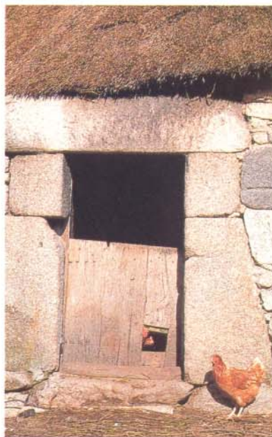
La palloza típica, de planta circular o elíptica, es una de las construcciones más arcaicas del noroeste peninsular. Arriba, la fachada de mayor superficie se orienta hacia el mediodía.
