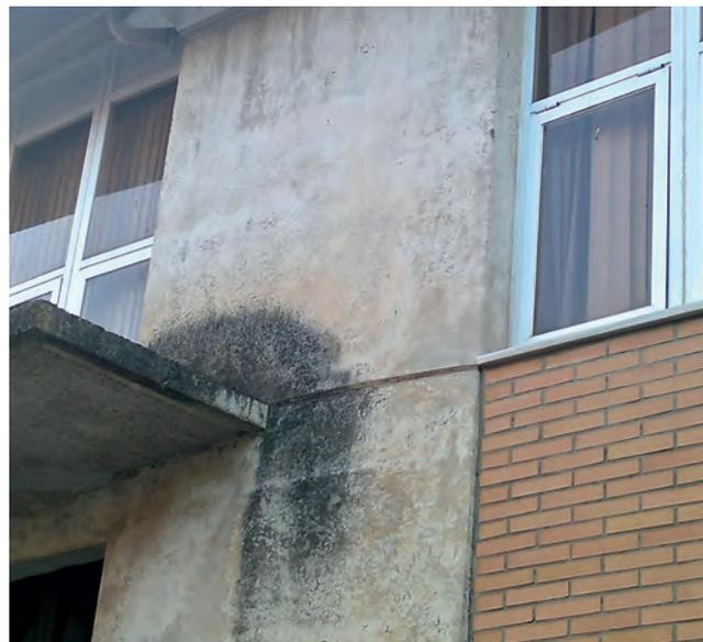
Figura 8: humedad debida a una solución inadecuada entre la fachada y el alero de hormigón.
