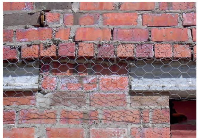
Figura 6: solución (mal ejecutada) en la que el dintel se realiza con vigueta doble T y se adiciona una malla metálica con solape en vertical insuficiente.
