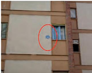
Figura 4: colocación de los termopares en la fachada.
