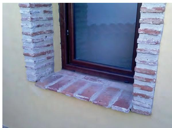
Figura 1: vierteaguas discontinuo realizado con ladrillo manual.
