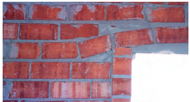
Figura 5: solución de dintel con arco de descarga.
