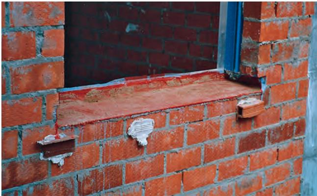
Figura 4: impermeabilización inferior de un vierteaguas.
