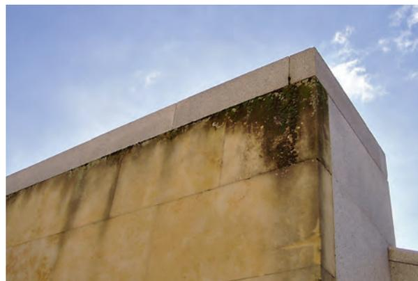
Figura 2: albardilla de granito sin vuelo sobre paramento inferior.
