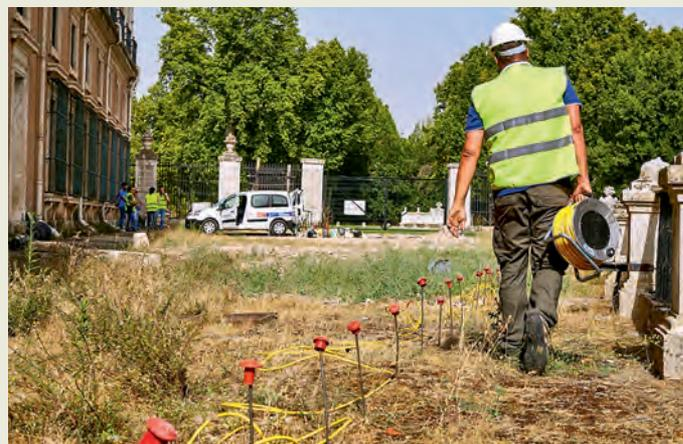
donde apoya la cimentación del muro y elevaría la superficie del terreno de manera controlada. La inyección de resinas expansivas permite una intervención rápida, sin contaminar, de forma que el drenaje del canal fuese de pocos días y no influyese en la fauna autóctona de la zona.
