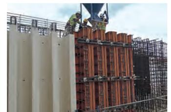
3 Para la estructura portante de hormigón armado blanco se emplean dos soluciones: los pilares exentos y los muros peine.
