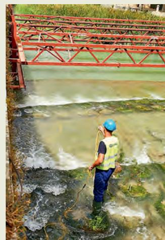
cauce, constará de 5 m con dos niveles de inyección. Compatiblemente con las estructuras y las instalaciones presentes se ejecutan una serie de perforaciones (de diámetro 20-30 mm) con un interje comprendido entre 0,50 y 1,50 m, tanto en el plano horizontal como en profundidad bajo la huella de la cimentación asentada para la realización posterior de las inyecciones.
