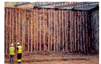
2 El desnivel y el movimiento de tierras hacen que la cimentación se realice con micropilones de profundidad variable hasta alcanzar el firme.
