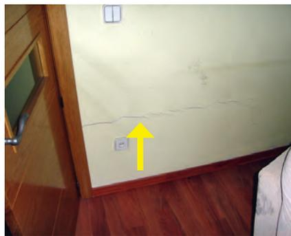
Fig. 8: fisura en tabiquería por deformaciones excesivas de forjados.
