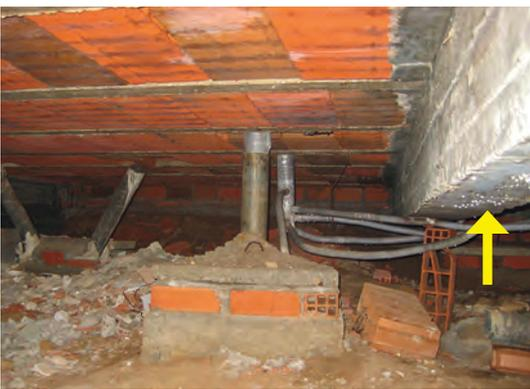
Fig. 14: ausencia de ventilación de cámara sanitaria. Condensaciones en cara inferior de la viga de hormigón.
