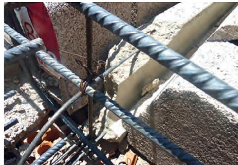
Fig. 5: descabezado de viga. Incorrecto.
