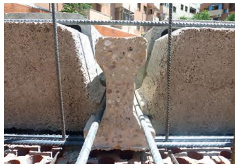
Fig. 6: apoyo de viga sobre zunchillo inferior de acero con ausencia de recubrimientos. Incorrecto.
