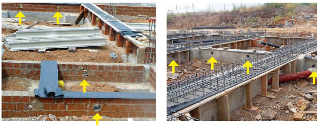
Fig. 22 y 23: apertura de ventilación en muros y/o vigas bajo forjado sanitario.
