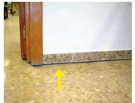
Fig. 9: separación tabique-solado por deformación del forjado.
