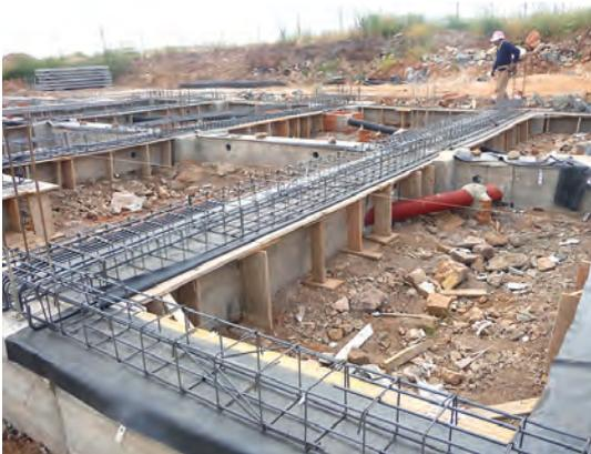
Fig. 20 y 21: barrera de corte de humedad en muros de apoyo de forjado sanitario.
