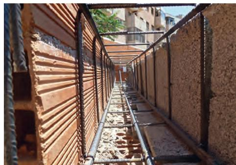
Fig. 7: ausencia de recubrimientos del armado de zunchillo lateral de forjado sanitario. Incorrecto.
