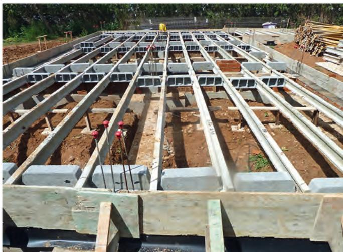
Fig. 1: vista general de montaje de viguetas de forjado sanitario.
