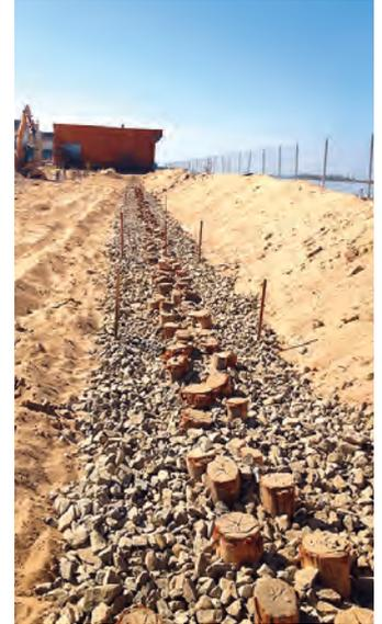
➤ suficiente para el reparto de cargas proveniente de los dos forjados superiores, transmitidas mediante el muro de hormigón que conforma la fachada. La ejecución de la cimentación fue laboriosa debido a los desniveles entre el patio de operaciones (-1,20) y el suelo del edificio (0,00), junto con los entrantes de los muelles de carga. Esto obligaba a dejar los encepados de esa zona a la cota más baja y tener que crear vigas de mayor canto que los arriostraran.
