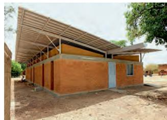
envuelve con un muro autoportante de ladrillo de tierra comprimida (BTC), dejando una cámara de aire ventilada intermedia. Este muro permite detener gran parte del calor exterior para mantener el interior fresco, al mismo tiempo que soporta la importante carga que supone la nueva cubierta metálica superior, sin sobrecargar los muros de la antigua construcción.
