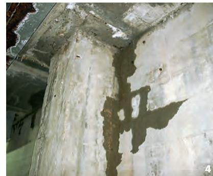
Fig. 4: muro de sótano. Filtración.
