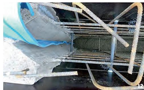
Fig. 12: junta de hormigonado y retracción.
