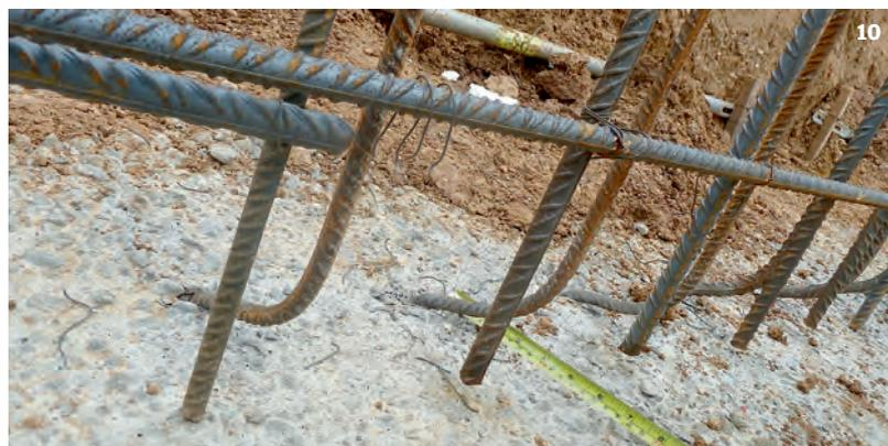
Fig. 10: grifado excesivo de las armaduras en espera del muro.
