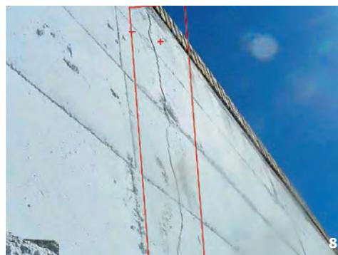
Fig. 7: desprendimiento por corrosión de armaduras.
