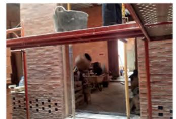
4 Las hiladas de ladrillo macizo se arman y los muros estructurales se estratifican en franjas entre antepechos y dinteles.
