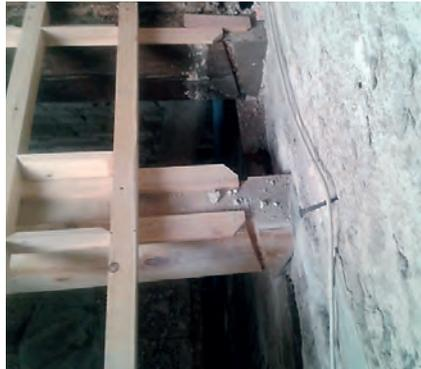
**La situación del antiguo lavadero,** formando esquina, era de ruina técnica. Solo se mantenían los muros. Las columnas del patio están reforzadas y, en algunos casos, revestidas por un muro de ladrillo. La actuación que se llevó a cabo fue consolidar los muros, reforzar y enderezar las columnas del patio y proyectar forjados de hormigón que sustituyesen a los inexistentes forjados originales. Una vez consolidados y arriostrados los
