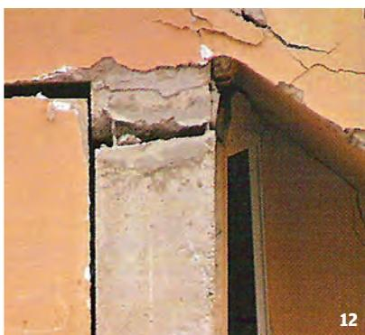
Fig. 11: fisuras por flexión.
