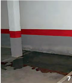
Fig. 8: humedades de filtración por fisuras en solera.
