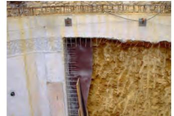
**1** Para excavar las dos plantas del sótano se ejecuta un precorte con perforaciones de 120 mm y 12 m de profundidad.
