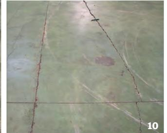
Fig. 9: fisuración por deficiente diseño de juntas o incorrecta ejecución.
