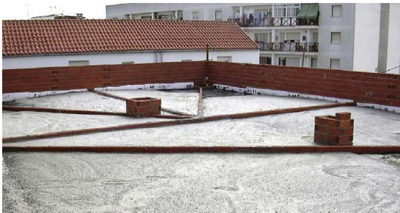
Figura 4: colocación de material elástico en el perímetro, realización de maestras de ladrillo y vertido de la formación de pendientes.
