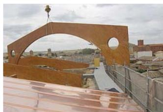
**3** Disposición de una cubierta de estructura de madera laminada, con una pendiente muy tendida y un recubrimiento de cobre.
