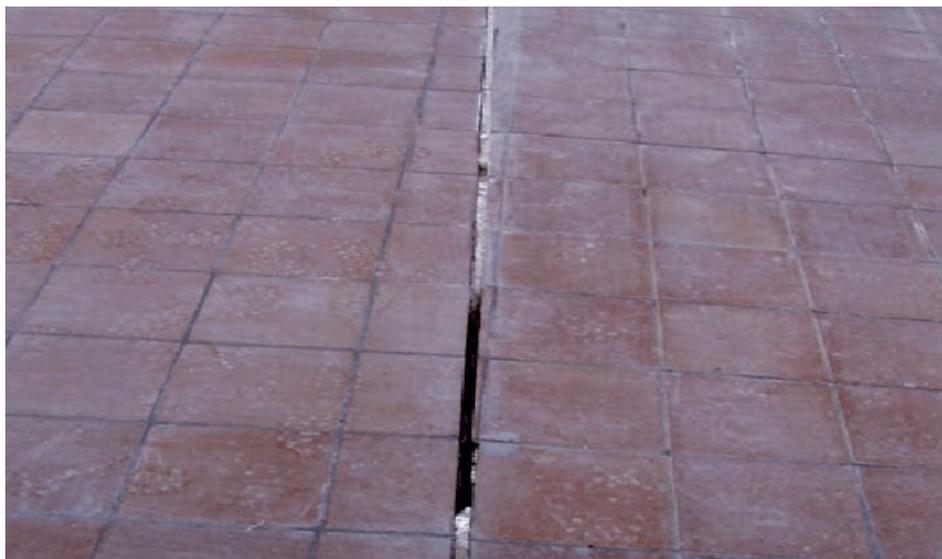
Fig. 2: Junta del acabado de protección en un solado fijo.
