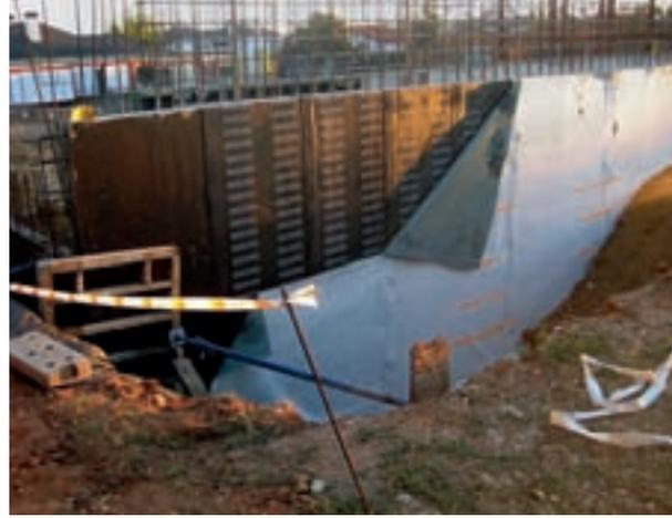
Fig. 5: Imprimación trasdós del muro (izquierda).
