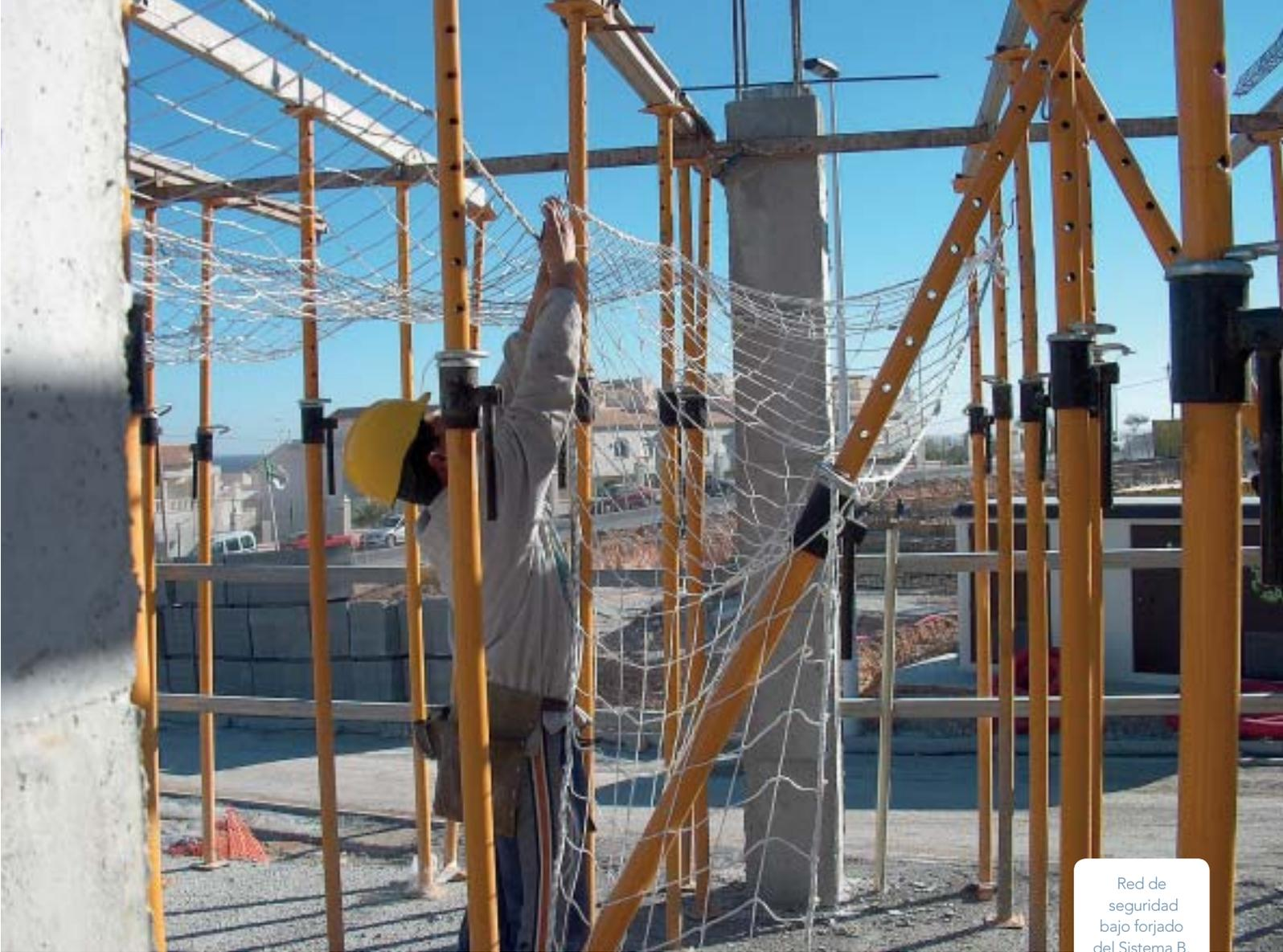
Red de seguridad bajo forjado del Sistema B.
