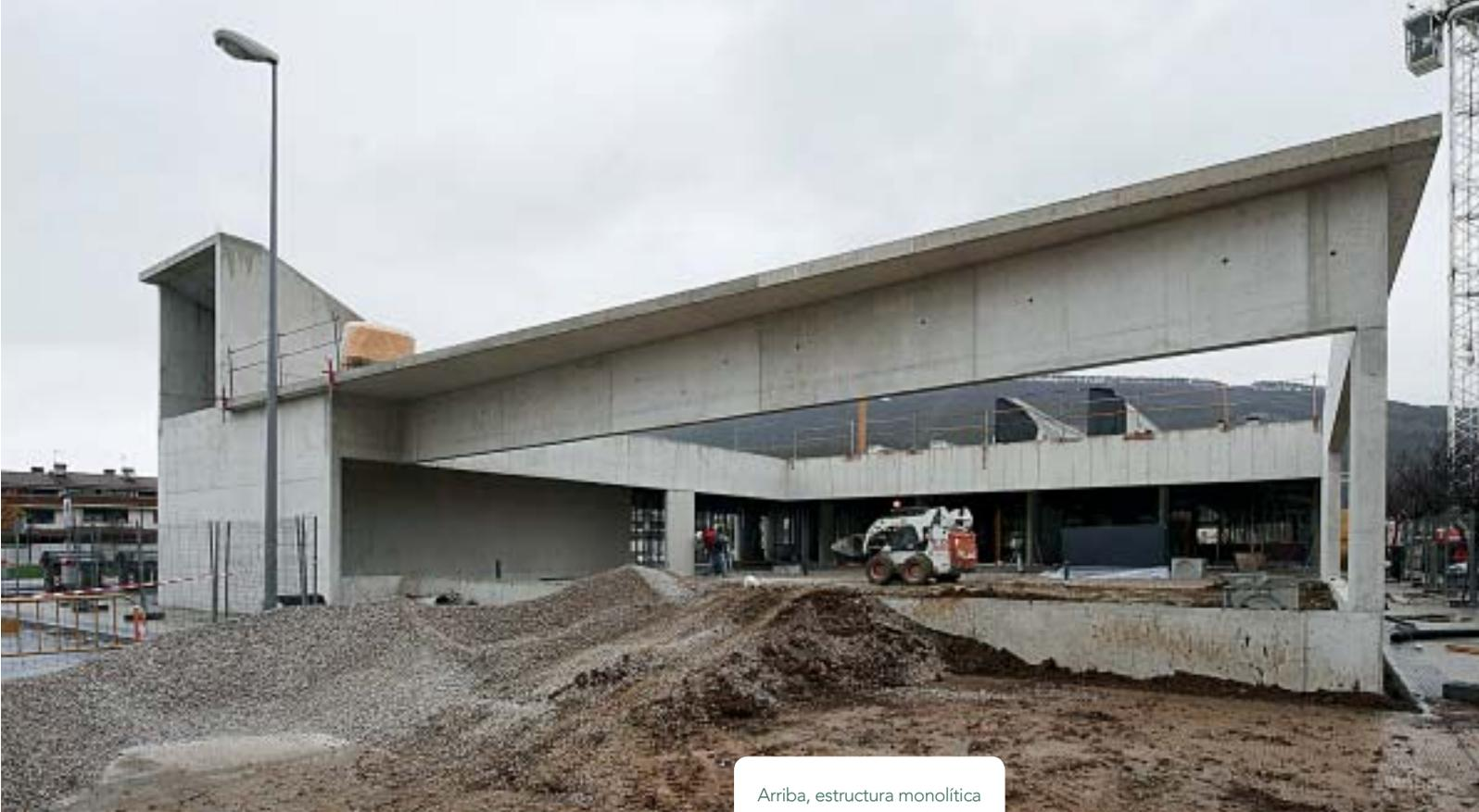
Arriba, estructura monolítica de hormigón. Abajo, izquierda, pantallas de hormigón y, a la derecha, muros de piñones de cubierta.
