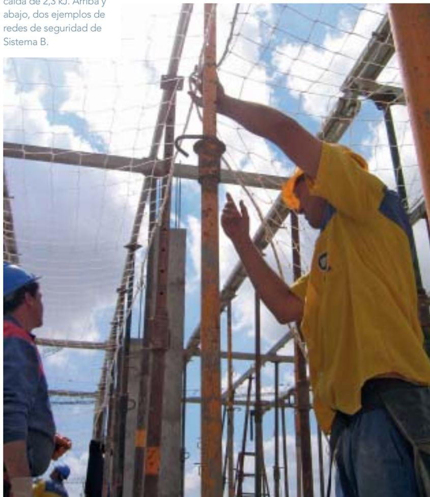
ga de su alojamiento y que la red no salga de ninguno de los anclajes. No deben permitirse roturas de anclajes, aunque sí se contemplan deformaciones permanentes en los anclajes.
