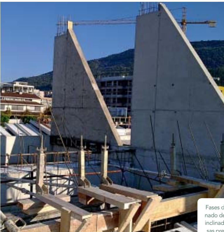
Fases de hormigonado de la cubierta inclinada, de prelosas prefabricadas.
