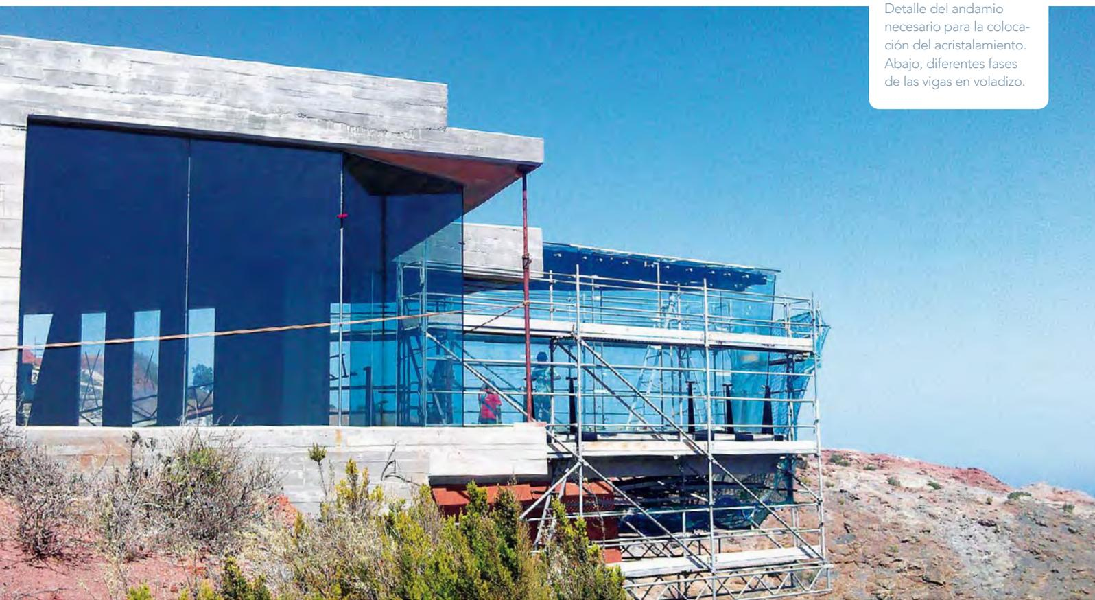
Detalle del andamio necesario para la colocación del acristalamiento. Abajo, diferentes fases de las vigas en voladizo.
