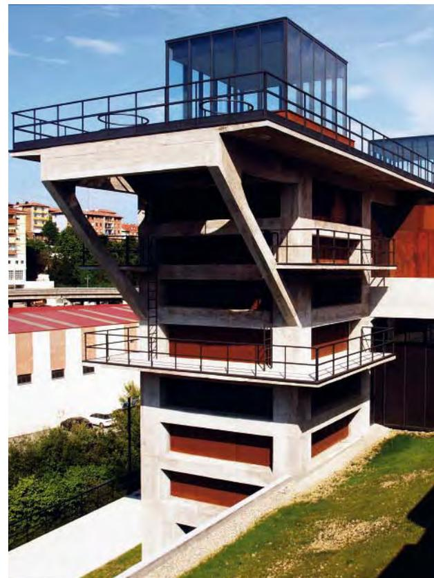
aunque poseía muy importantes fisuraciones y desprendimientos en sus superficies, fundamentalmente por las acciones mecánicas y térmicas de la actividad industrial original, así como por corrosión de las armaduras debido al ataque de  $\text{CO}_2$ ,  $\text{O}_2$  y a la humedad. Por dicho motivo, los paramentos de la estructura de hormigón debieron ser restaurados en una gran proporción.
