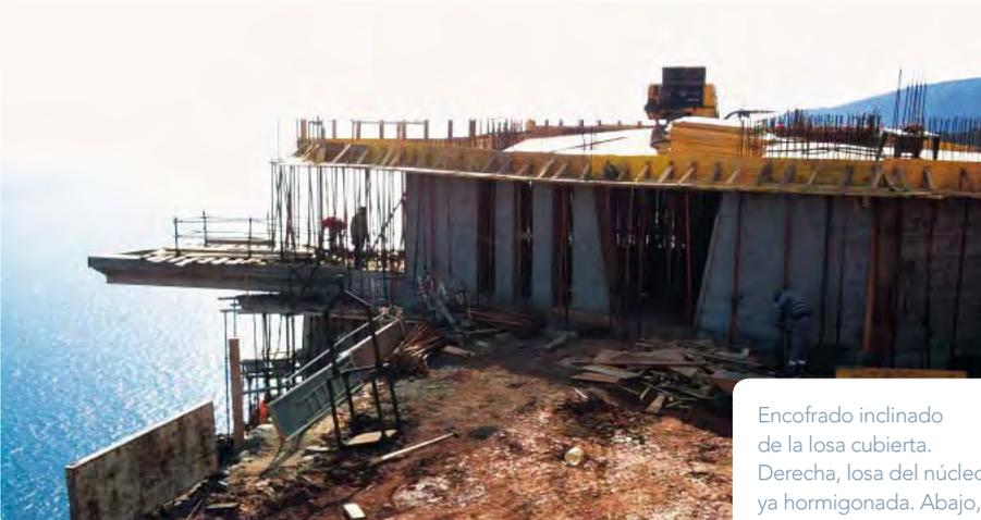
Encofrado inclinado de la losa cubierta. Derecha, losa del núcleo ya hormigonada. Abajo, trabajos de colocación de vidrio en el voladizo.
