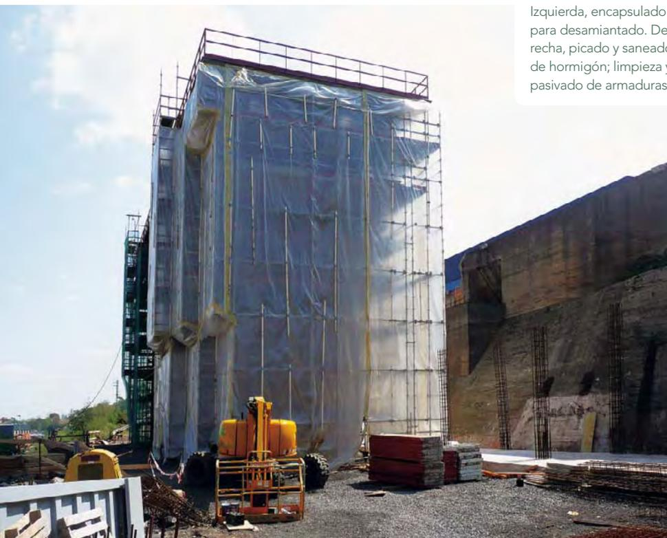
Izquierda, encapsulado para desamiantado. Derecha, picado y saneado de hormigón; limpieza y pasivado de armaduras.
