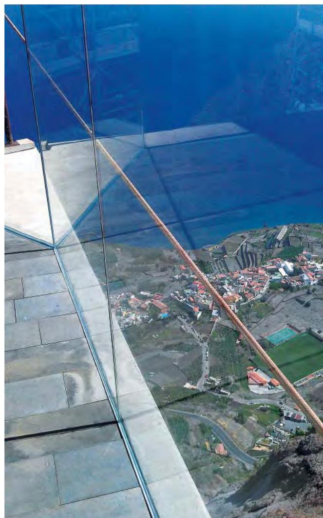
“ El piso de vidrio, con una luz máxima de 2,40 m, se realiza con cuatro componentes de vidrio termoendurecidos, de 10 mm de espesor, y un peso de 100 kg/m<sup>2</sup> con tratamiento antideslizante en su cara superior para evitar resbalones y cumplir con el DB de Seguridad Estructural del CTE ”
