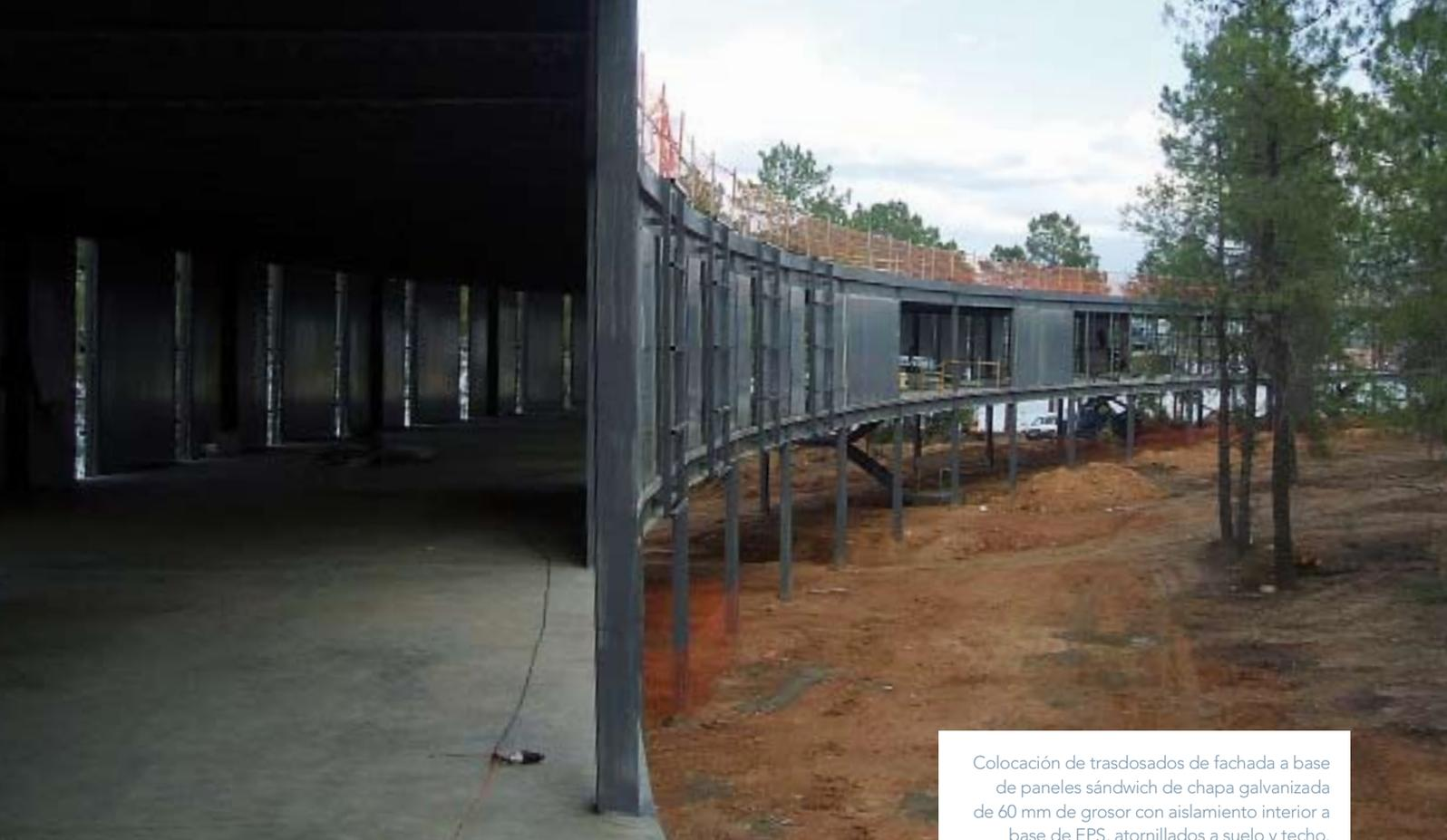
Colocación de trasdosados de fachada a base de paneles sándwich de chapa galvanizada de 60 mm de grosor con aislamiento interior a base de EPS, atornillados a suelo y techo.
