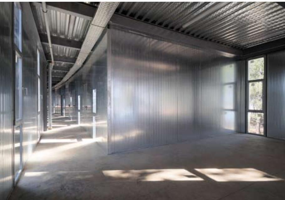
completa de su entorno. Está realizada con una solera de hormigón fratasada antideslizante, dotada de una sola pendiente hacia en interior dispuesta sobre aislamiento y dos capas de láminas impermeabilizantes.
