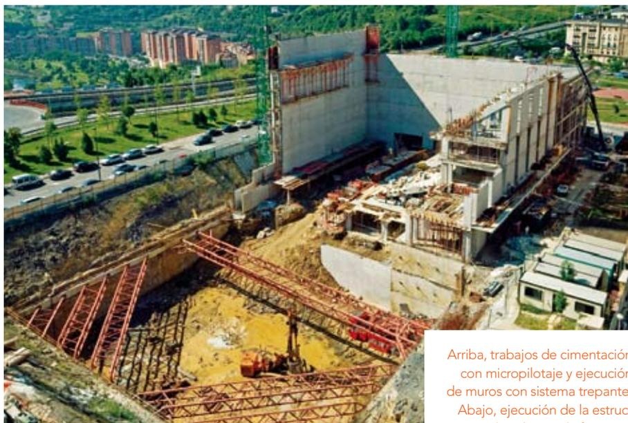
Arriba, trabajos de cimentación con micropilotaje y ejecución de muros con sistema trepante. Abajo, ejecución de la estructura de cubierta de frontón y gradas de trinquete.
