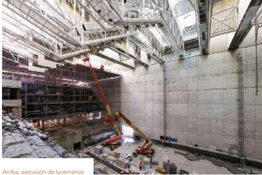
Arriba, ejecución de lucernarios y cimbra de gradas traseras. Abajo, cimbra y ejecución de la cubierta del trinquete.
