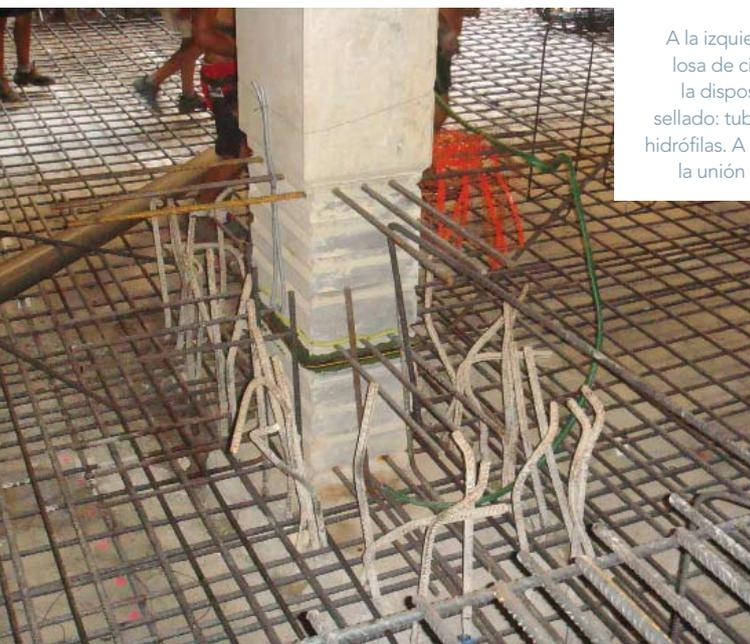
A la izquierda, unión del pilar y la losa de cimentación. Se observa la disposición de elementos de sellado: tubo de inyección y juntas hidrófilas. A la derecha, montaje de la unión del pilar con el forjado.
