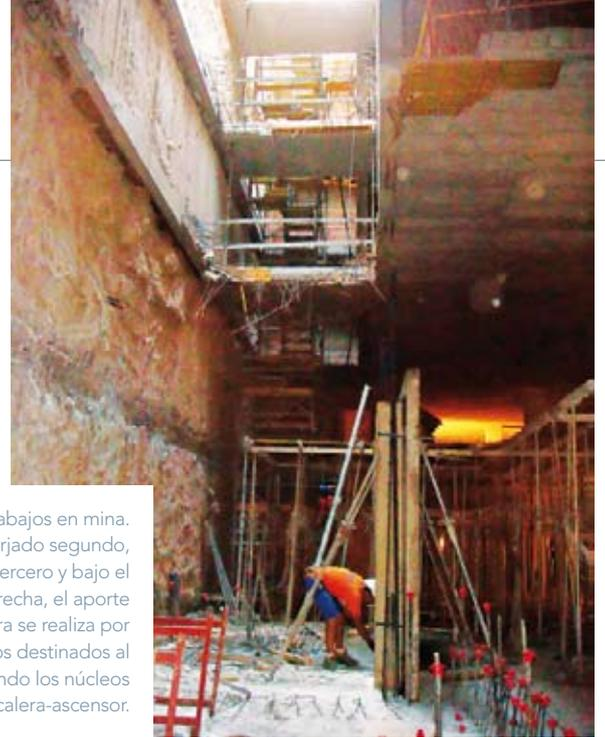
A la izquierda, trabajos en mina. Montaje del forjado segundo, encofrado sobre el tercero y bajo el de cubierta. A la derecha, el aporte de materiales a la obra se realiza por medio de los huecos destinados al efecto, aprovechando los núcleos de escalera-ascensor.
