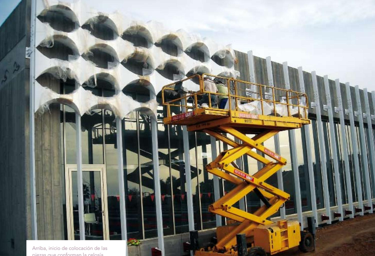
Arriba, inicio de colocación de las piezas que conforman la celosía. Abajo, disposición de las reglas transversales para la interrupción del pavimento y, con ello, realizar paños alternos para la ejecución de las juntas.
