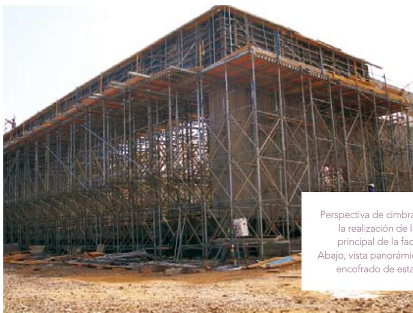
Perspectiva de cimbra para la realización de la viga principal de la fachada. Abajo, vista panorámica del encofrado de esta viga.
