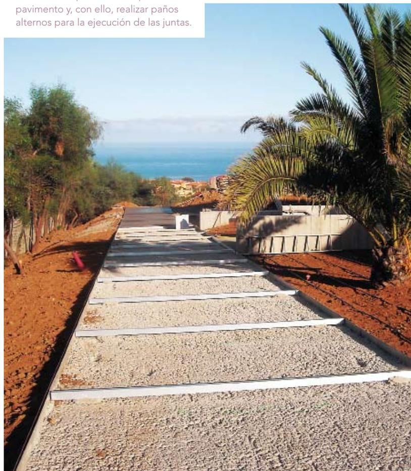
de aluminio a modo de rodapié que, al componerse de dos piezas, sirve como elemento auxiliar y guía para la ejecución del revestimiento, permitiendo que, finalmente, quedase embutido en él.
