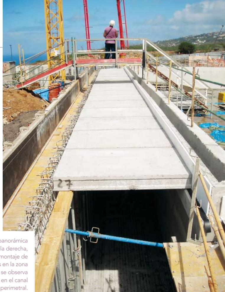
A la izquierda, panorámica de la fachada. A la derecha, detalle del montaje de placas alveolares en la zona de playa, donde se observa su apoyo en el canal rebosadero perimetral.
