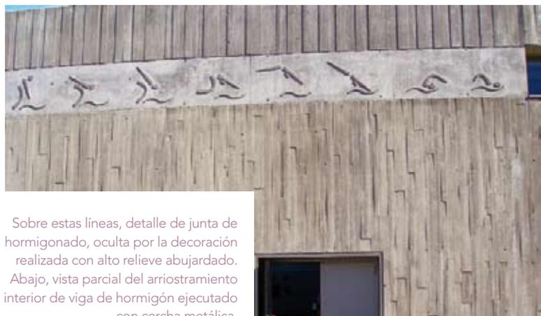
Sobre estas líneas, detalle de junta de hormigonado, oculta por la decoración realizada con alto relieve abujardado. Abajo, vista parcial del arriostramiento interior de viga de hormigón ejecutado con cercha metálica.
