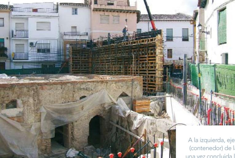
A la izquierda, ejecución del muro perimetral (contenedor) de la obra nueva. A la derecha, una vez concluida la envolvente de hormigón.
