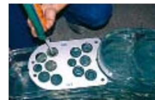
Arriba, a la izquierda, distribución de adhesivo en la junta horizontal entre bloques de vidrio. Abajo, el muro de vidrio durante su construcción. A la derecha, sellando el muro.
