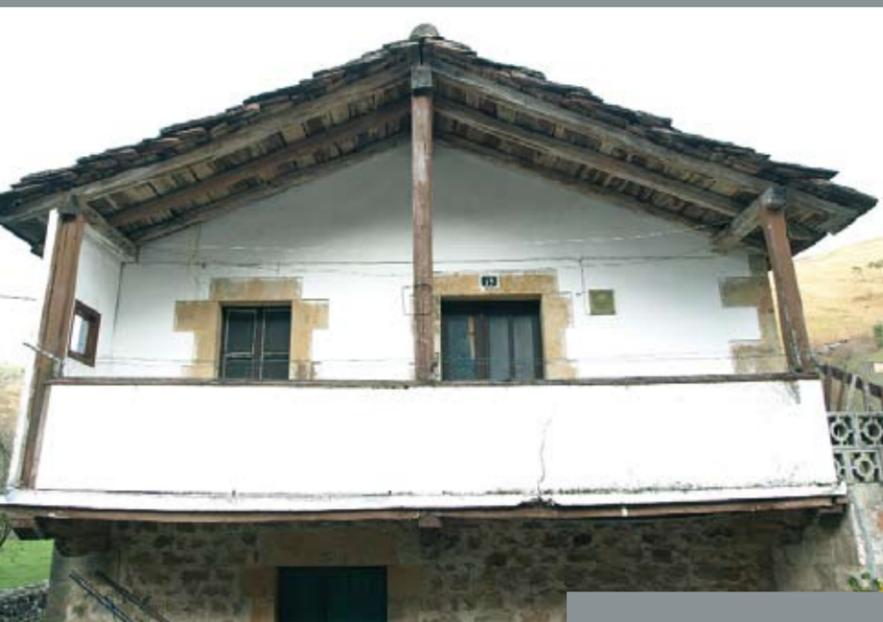
Arriba, transformación de una cabaña en vivienda con añadido de solana. A la izquierda, cabaña con ampliación lateral. Al lado, cabaña con hastiales.
