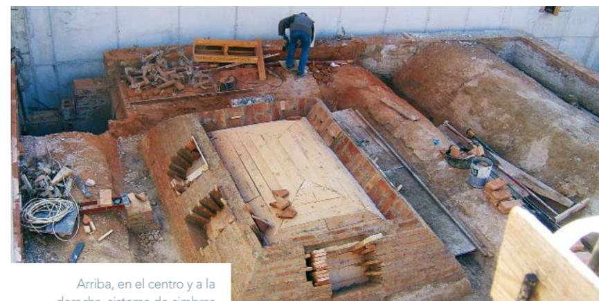
Arriba, en el centro y a la derecha, sistema de cimbras empleados para la reconstrucción de las bóvedas. Las otras dos imágenes muestran la restitución de la bóveda central en la sala templada.
