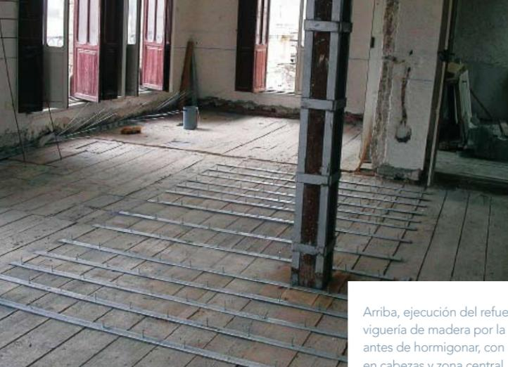
Arriba, ejecución del refuerzo metálico de vigería de madera por la parte superior antes de hormigonar, con acero laminado en cabezas y zona central, además de conectores de acero corrugado. Abajo, el salón de plenos con los elementos decorativos desmontados. A la derecha, decoración de la sala de alcaldía, con suelo de piezas de gres, zócalo de madera policromada y paredes revestidas de papel pintado adherido a arpillería.
