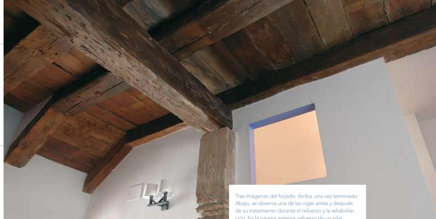
Tres imágenes del forjado. Arriba, una vez terminado. Abajo, se observa una de las vigas antes y después de su tratamiento durante el refuerzo y la rehabilitación. En la página anterior, refuerzo de un pilar.
