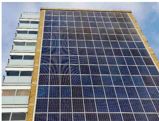
Esta solución requiere simplemente de la sustitución de los paneles de vidrio comunes por los paneles solares ya que el sistema de fijación sería muy similar. Estos paneles tienen la peculiaridad que además de ser productores de energía tienen que cumplir con las funciones de cerramientos e iluminación que le corresponde a toda la fachada.
