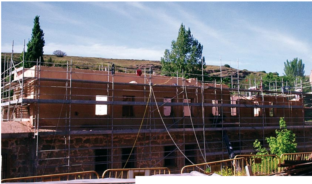
Las fachadas se revestirán con morteros bastardos imitando los que tenía en su origen.
