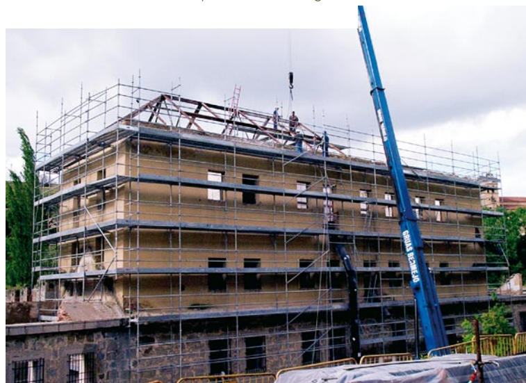
Las fachadas se revestirán con morteros bastardos imitando los que tenía en su origen.
