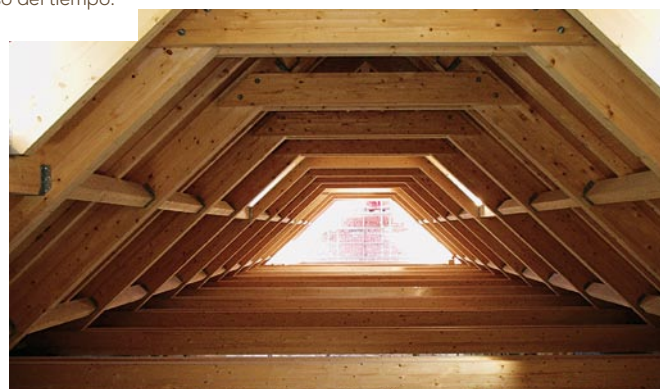
Las cubiertas se han resuelto con cerchas de madera laminada y cubrición de pizarra. En su interior se han restaurado los sillares de caliza existentes, que estaban muy deteriorados debido al paso del tiempo.
