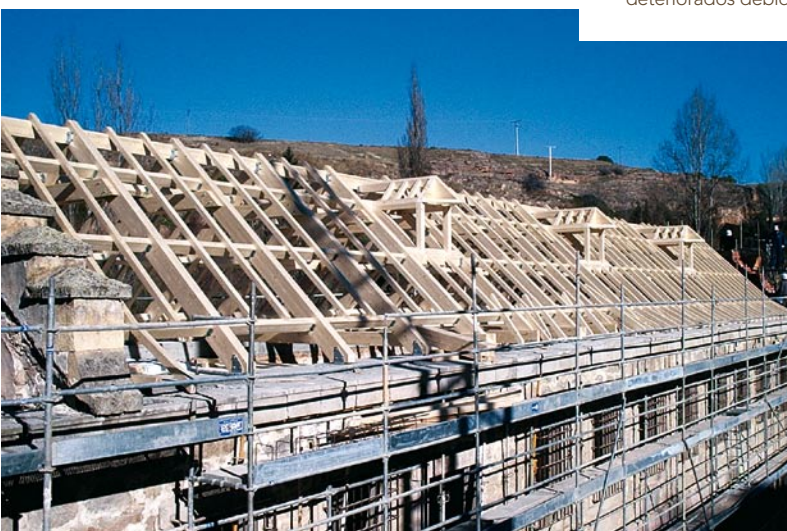
Las cubiertas se han resuelto con cerchas de madera laminada y cubrición de pizarra. En su interior se han restaurado los sillares de caliza existentes, que estaban muy deteriorados debido al paso del tiempo.
