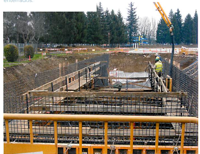
Vista de la excavación y cimentación de los grandes depósitos de compensación enterrados.
