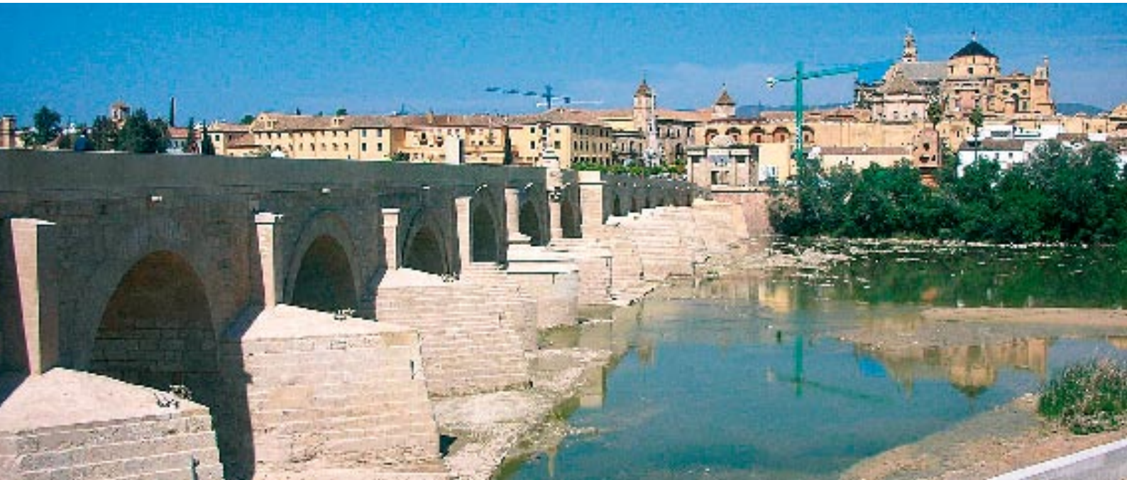
Arriba, aspecto actual del puente. A la izquierda, estado de dos escudos renacentistas en clave de arcos aguas arriba. A la derecha, estado actual de la fachada aguas abajo.
