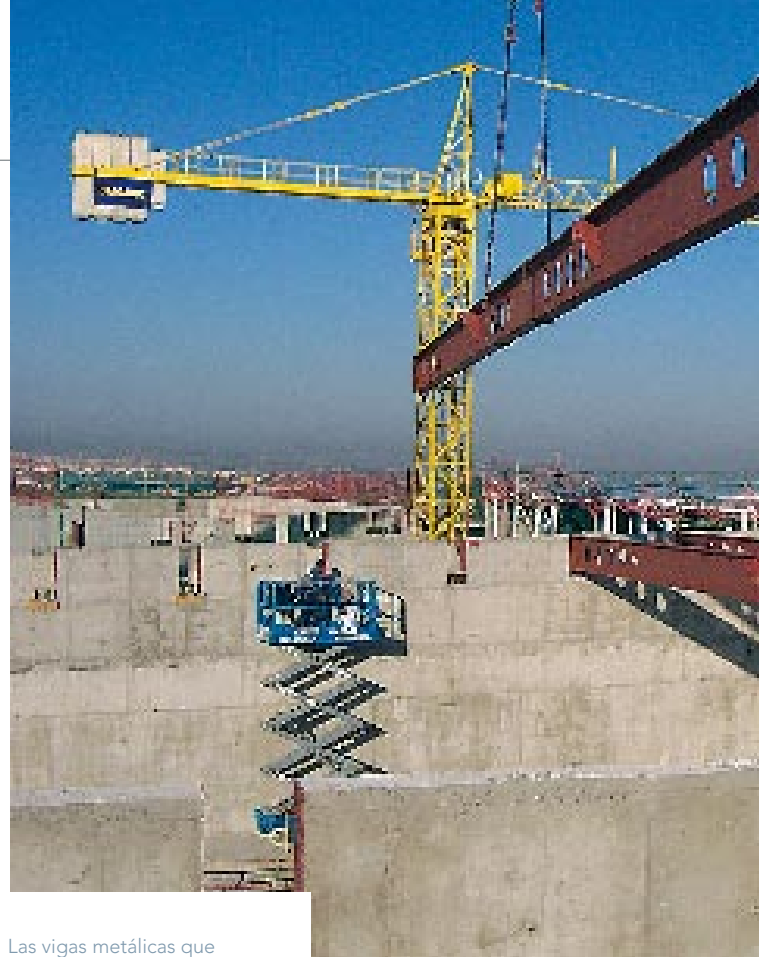
Las vigas metálicas que sustentan la estructura precisaron de maquinaria especial para su transporte y posterior colocación. Abajo, vista aérea del recinto.
