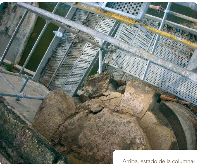
Arriba, estado de la columna-basamento en el arranque de la hornacina. Abajo, curva de replanteo encuentro de tablero con la torre de la Calahorra tras retirar el hormigón.
