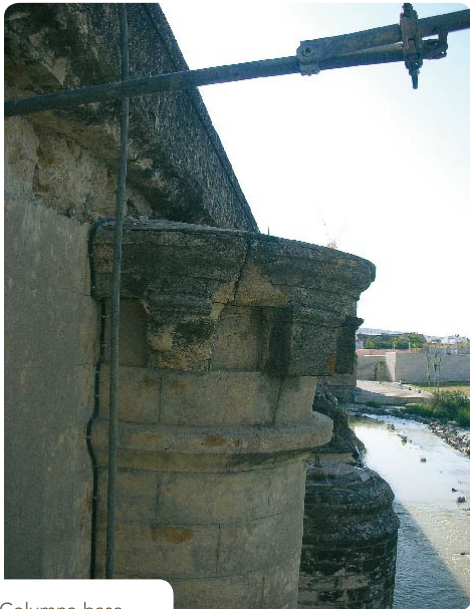
Columna-basamento de apoyo con la hornacina desmochada.
