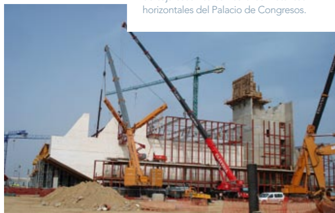
Muro de hormigón blanco de cerramiento de caja escénica con cerchas metálicas horizontales del Palacio de Congresos.
