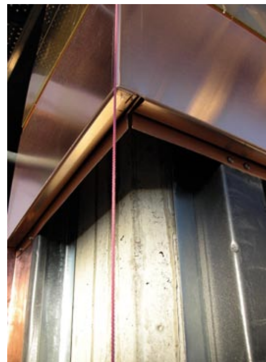
Prácticamente toda la superficie del edificio está cubierta de cobre, formando una segunda piel sobre la estructura, que aporta textura, color y brillo a toda la construcción.
