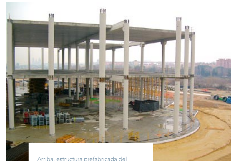
Arriba, estructura prefabricada del Pabellón de Participantes. Abajo, fachada de panel sándwich de este pabellón. A la izquierda, vista aérea de los terrenos de la Expo de Zaragoza.
