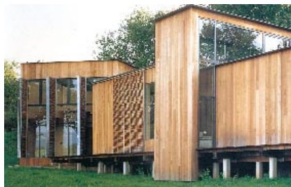
Casa realizada totalmente de madera elevada para evitar la entrada de humedad.
