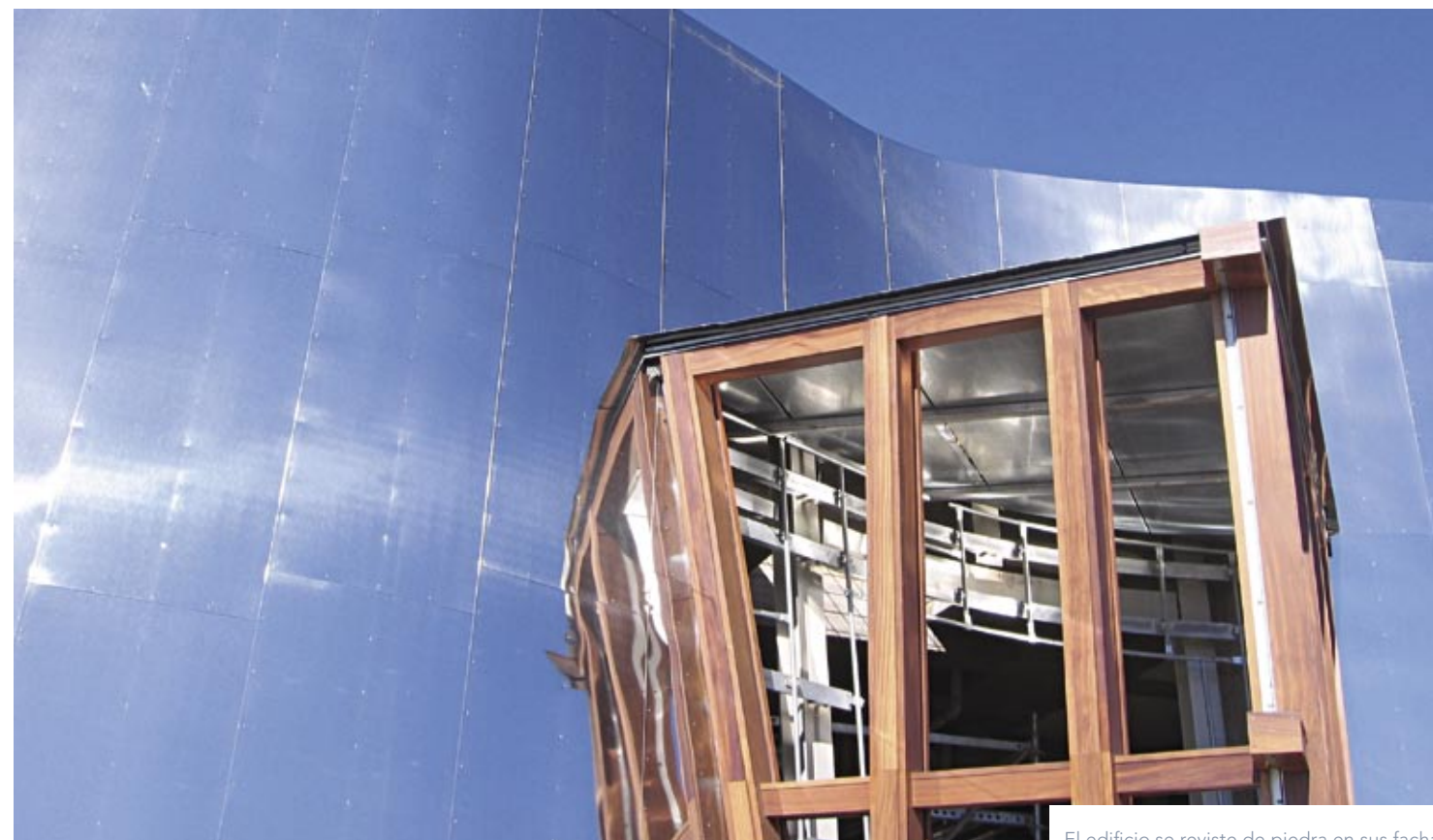
El edificio se reviste de piedra en sus fachadas rectas, y de titanio y acero inoxidable en las curvas, abriendo grandes ventanales, especialmente entre canopies. Los vanos son todos diferentes entre sí –rectangulares, triangulares, trapezoidales y romboidales–, y muchos de ellos con complejas orientaciones e inclinaciones que, además de abrir la construcción al paisaje, tamizan la luz exterior.
