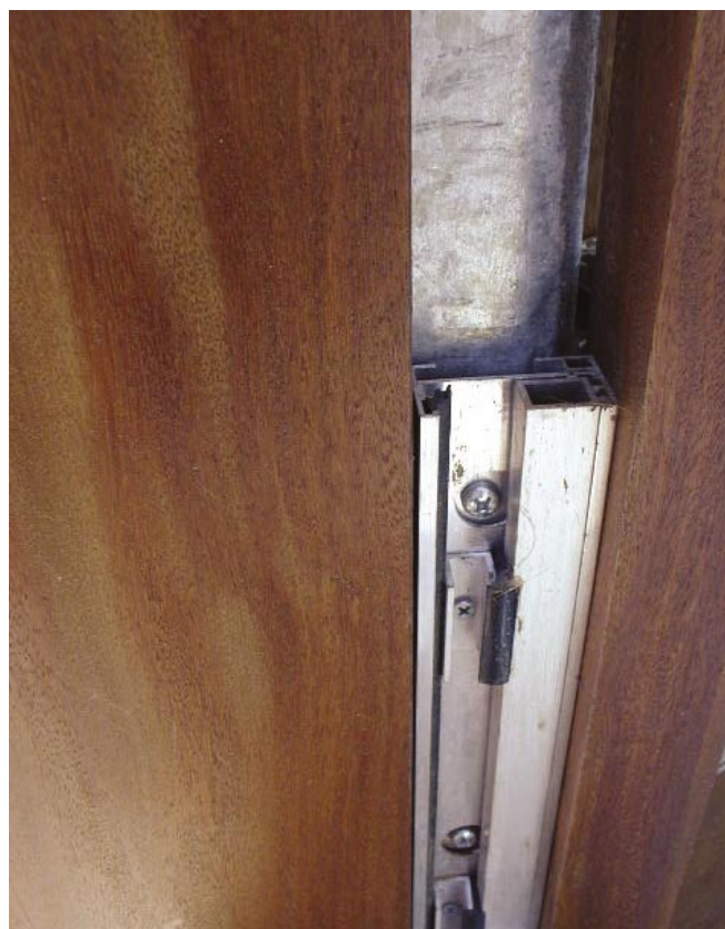
Los más de mil metros cuadrados de ventanales están enmarcados en una carpintería mixta con alma de acero galvanizado, marcos de aluminio, y todo ello revestido en madera de Elondo.
