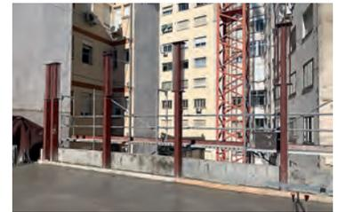
**2** La fachada posterior está formada por vigas de gran canto de hormigón armado y pilares metálicos, que dan soporte a la fachada de ladrillo y conforman los huecos
