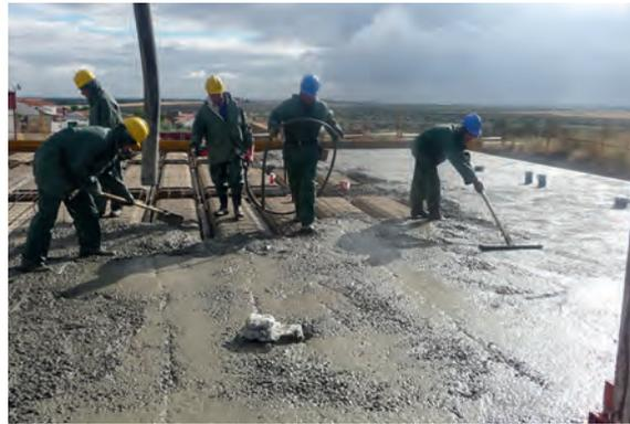
Fig. 5: vertido y compactado del hormigón en obra.
