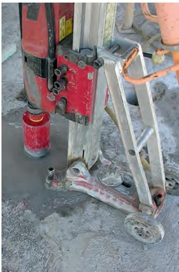
Fig. 8: extracción probetas testigos.
