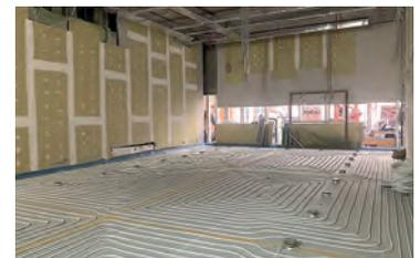
**4** El suelo radiante de las plantas baja y primera funciona con agua tanto en invierno (a una temperatura de 40 °C) como en verano (con el agua a una temperatura de 15 °C).
