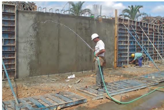
Fig. 7: curado del hormigón en obra.
