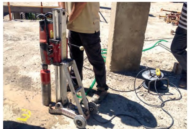
Fig. 1: extracción probeta testigo de hormigón.
