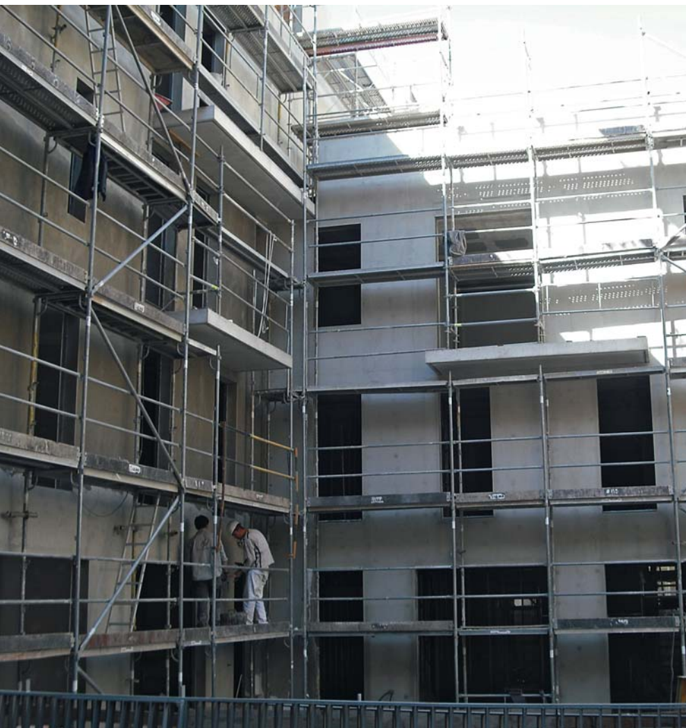
Imágenes de la fachada interior, una vez colocado el aislamiento (ETIC) y previamente a su revestimiento.
