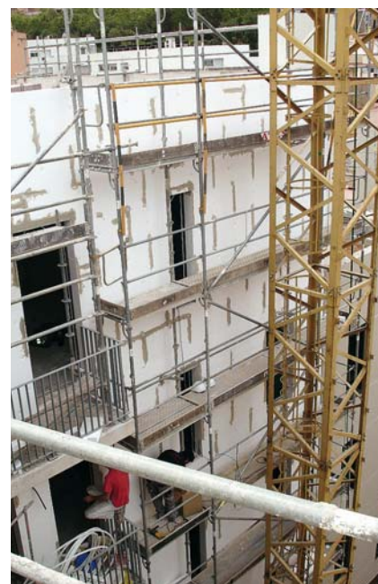
Imágenes de la fachada interior, una vez colocado el aislamiento (ETIC) y previamente a su revestimiento.
