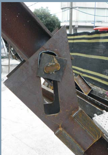
Detalle de los gatos hidráulicos utilizados durante la operación de izado de este edificio de Galicia.
