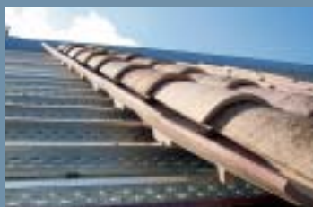
Colocación de tejas
