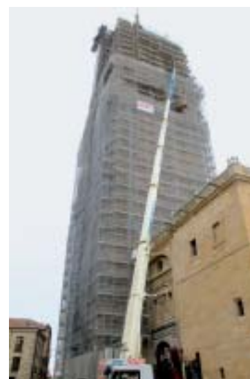
Suministro de las vigas del forjado mediante una grúa móvil, accediendo por el hueco de las campanas a más de 40 metros de altura.
