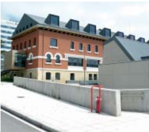
Vista del único vestigio del antiguo psiquiátrico de La Cadellada, una vez rehabilitado.
